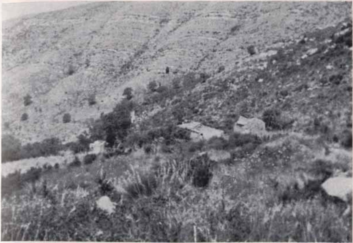
Fig. 3. — Costruzioni residue del villaggio di Montanari, abitato fino a un trentennio addietro, sito a 550 m sul versante occidentale del Monte della Stella nel Cilento.
