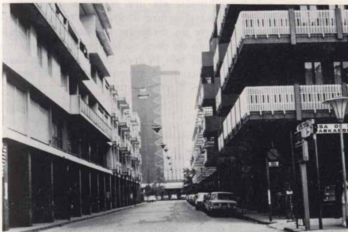
Fig. 5. — Via Jappelli, una delle strade del « passeggio », ove le recenti costruzioni accolgono gli esercizi commerciali più esclusivi.
