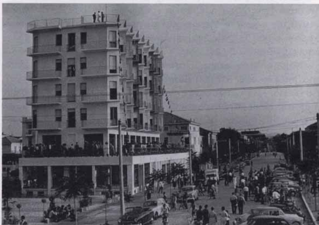
Fig. 9 - Pesaro. Viale Marconi, inaugurazione nel 1956 dell'Hotel Brig (dal 1994 "Rossini") di proprietà del Conte Albani.
