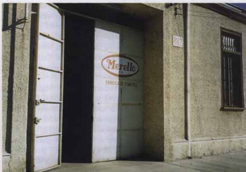
Fig. 105 - Limache: esterno della fabbrica di caramelle di Raynaldo Merello.
