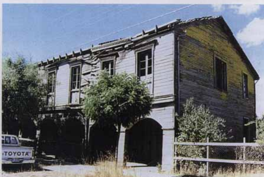
Fig. 53 - Capitán Pastene: la casa dei Fratelli Ricci, fondatori della colonia, che ora è stata demolita.
