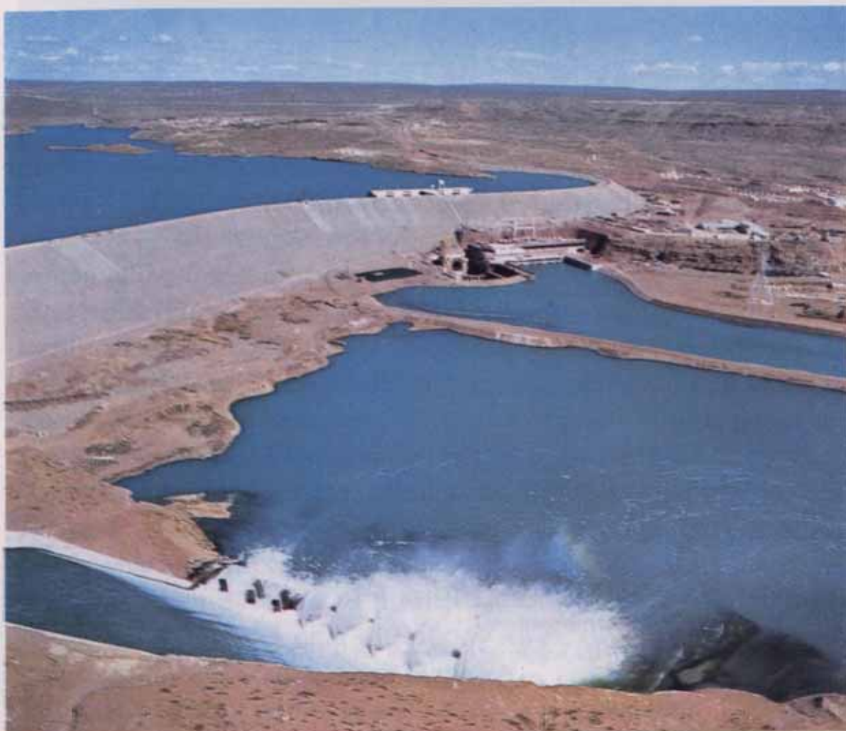
Fig. 6 - La diga in terra battuta di El Chocón, con la centrale ed i canali di deflusso. Si notino le varietà di colore dei materiali sedimentari e l'ambiente semidesertico.
