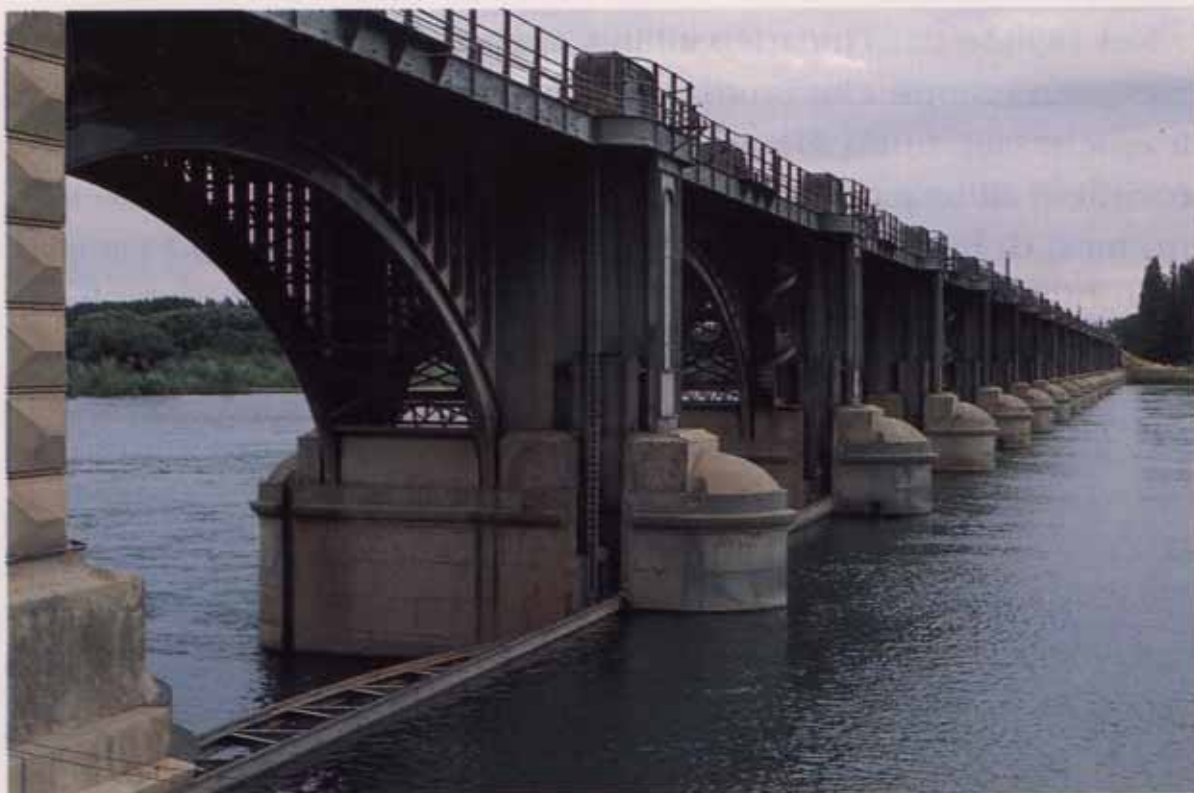
Fig. 5 - La diga Ingeniero Ballester (Fot. N. Castiello).
