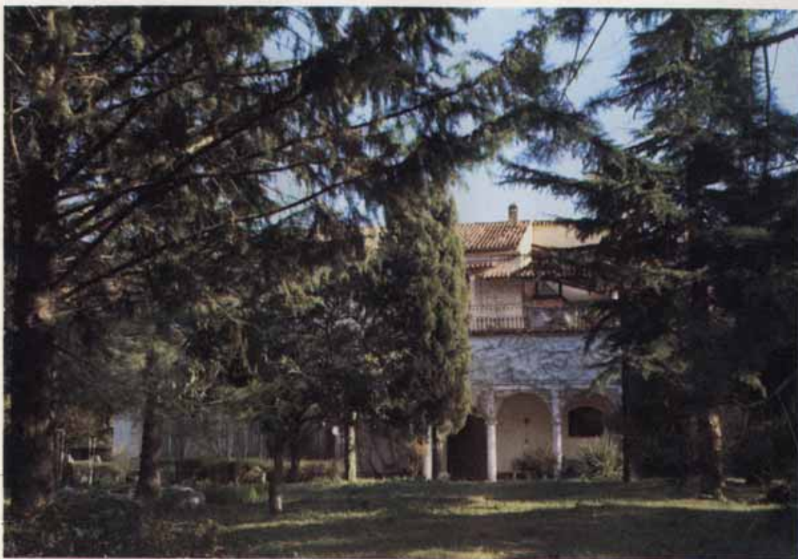
Fot. 30. - Masseria Ceraverecce a Pontelatone . La costruzione, del XVIII secolo ed in buono stato di conservazione, sorge su un terreno boschivo medio collinare. Il suo toponimo derivava infatti dalla presenza di cervi e daini sul fondo annesso e ciò accredita la tesi che la tenuta fosse utilizzata come luogo di caccia. La forma a blocco è restata inalterata, nonostante l'aggiunta di nuovi corpi di fabbrica ed una parziale ristrutturazione che ha mutato la destinazione degli ampi servizi rurali, perché, esaurita l'originaria funzione residenziale, oggi è utilizzata come azienda vitivinicola. Strutturata su due livelli e scantinati, presenta una caratteristica cappella nei pressi del vecchio viale di accesso, circondato da ampio giardino con alberi secolari e con un antico pozzo.
