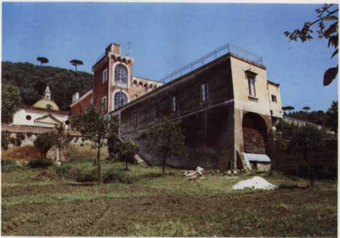
Fot. 2. - Villa Grado del duca di Tixon de Vidaurres a Maddaloni. Villa extraurbana di notevoli dimensioni, con cantine e depositi, edificata nel XIX secolo e in buono stato. Ha una forma a blocco, due livelli con scantinati, belvedere e cappella. Il corpo avanzato accoglie le abitazioni per la servitù. Oggi è residenza non agricola.
