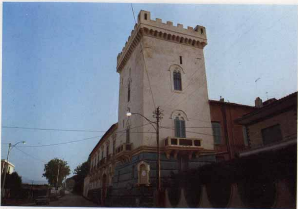
Fot. 8. - Villa Porfidia a Recale . Grande villa extraurbana del XVIII secolo, con ampio giardino, legata allo sfruttamento fondiario (colture seminate), è in buono stato di conservazione e presenta una forma ad L, due o tre livelli ed un'imponente torre, completamente ristrutturata. Sita in zona medio collinare, aveva un tempo funzione agricolo-residenziale, come testimoniano gli ampi servizi rurali; oggi invece è residenza non agricola.
