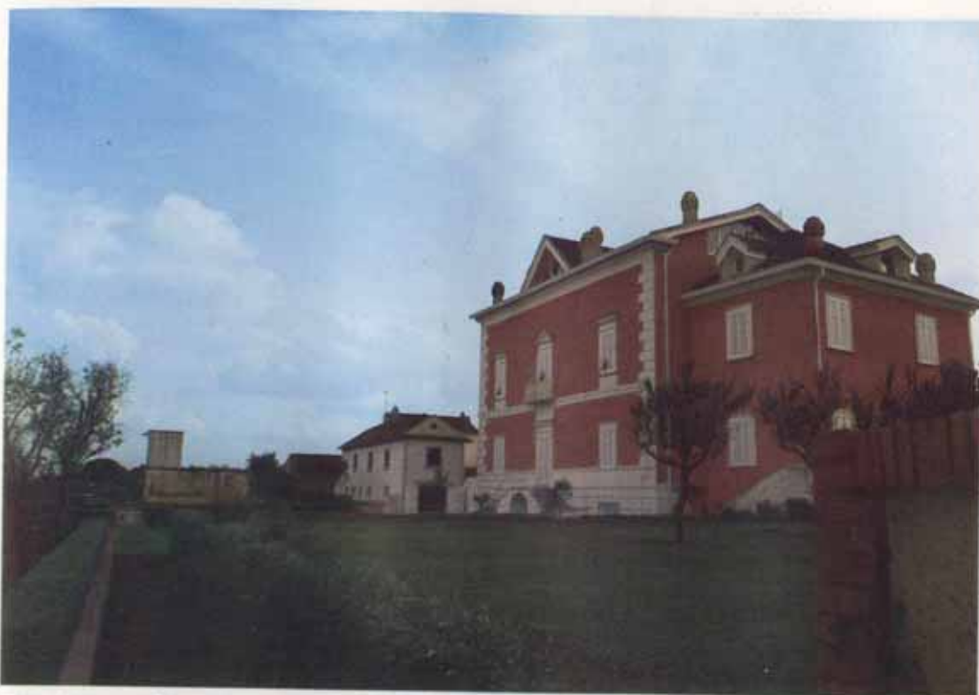
Fot. 9. - Villa Maggìo a Casagiove . Villa extraurbana di grandi dimensioni del XVIII secolo, con giardino, legata allo sfruttamento fondiario (parte a colture seminate e parte a bosco). Presenta: una forma a blocco, un ottimo stato di conservazione, perché recentemente è stata ristrutturata, due livelli con sottotetto ed un tetto mansardato e a falde. Sita in zona medio collinare, in origine essa aveva una funzione agricolo-residenziale. Attualmente i servizi rurali sono stati trasformati in scuderie e fienili e la villa è divenuta residenza non agricola e sede di un circolo ippico privato. Alcuni corpi di fabbrica, in prossimità dell'edificio principale, sono stati aggiunti in periodi successivi ed ora sono adibiti ad usi diversi.
