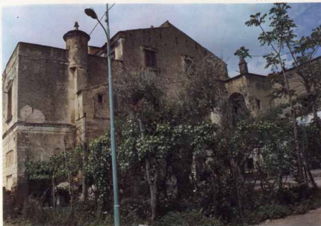
Fot. 16. - Villa Nuzzo a Santa Maria a Vico . È una grande costruzione extraurbana, a corte chiusa, con parco giardino legata allo sfruttamento fondiario. Attualmente disabitata, un tempo era utilizzata a scopi agricolo-residenziali. Sita in zona collinare, è stata edificata nel XIX secolo ed oggi è in discreto stato di conservazione. Presenta due livelli con sottotetto ed ampi servizi rurali. La sua struttura è stata modificata con l'aggiunta di corpi di fabbrica che non hanno alterato i caratteri edilizi originari. Sul fondo annesso venivano praticate colture legnose.
