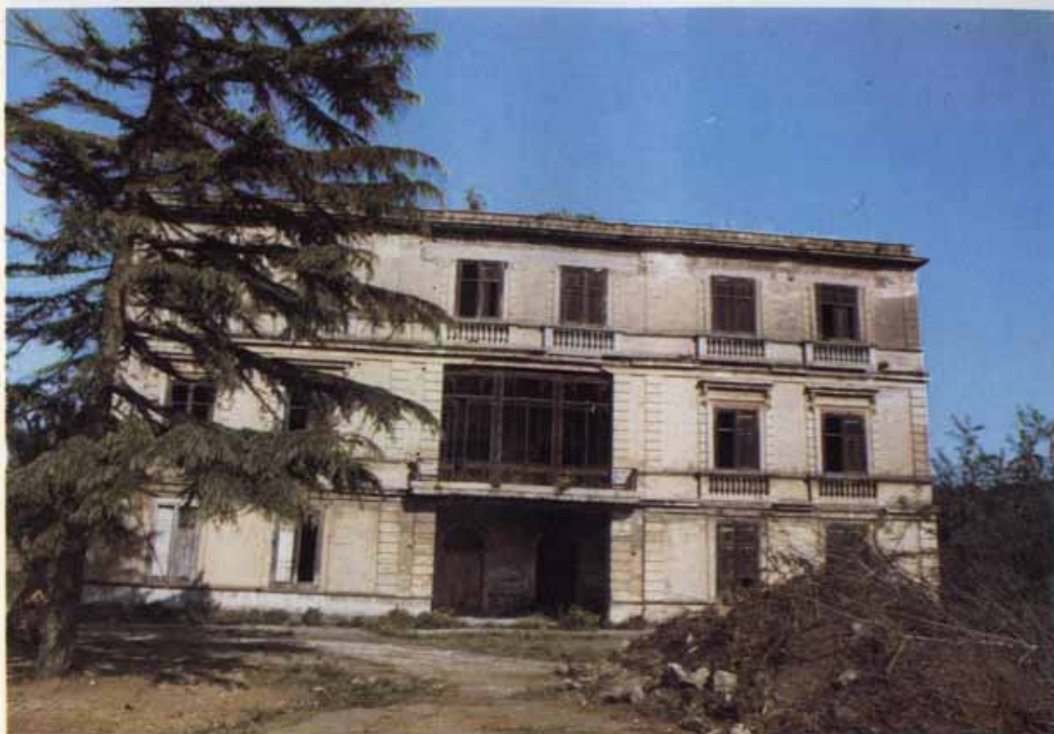
Fot. 41. - Casino del conte Mesolella a Sparanise . Utilizzata anche come casino di caccia, la costruzione è da considerarsi un tipico esempio di grande villa extraurbana di sola rappresentanza, con parco giardino, non legata allo sfruttamento fondiario. Costruita in pianura nel XIX secolo con forma a blocco, l'edificio, che versa in cattivo stato di conservazione, assolveva ad una funzione residenziale, per cui non disponeva di fondi rustici, ma solo di taluni servizi rurali (cantina e depositi). Strutturata su tre livelli, con balconcino centrale e alloggi per la servitù sul retro, non ha subito alcuna trasformazione ed oggi è disabitata.
