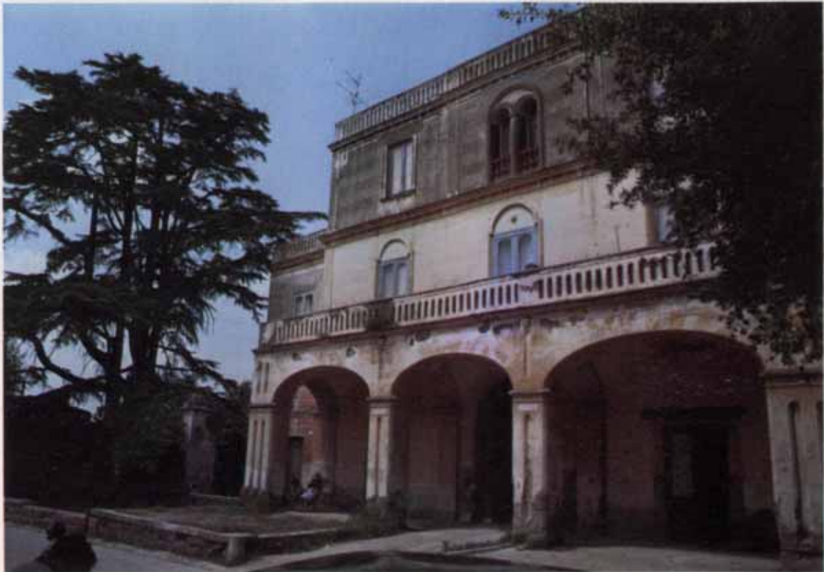
Fot. 44. - Palazzo Russulillo a Sant'Angelo in Formis (frazione di Capua) . Edificio a blocco del XIX secolo, contornato da fondo rustico con colture legnose, in discreto stato di conservazione. Strutturato su tre livelli, aveva funzione agricolo-residenziale, mentre oggi è utilizzato solo come abitazione ed i servizi rurali, posti sul retro, hanno subito trasformazioni evidenti. I due terrazzi laterali e quello sul tetto permettono di godere di un bel panorama, essendo l'edificio posto in zona collinare.
