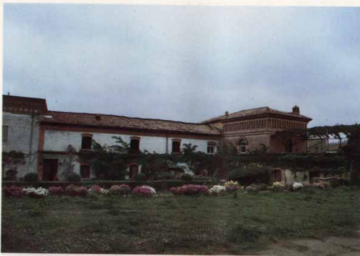
Fot. 50. - Castello De Renzis in località Montanaro (comune di Francolise). Edificio urbano del XIX secolo con parco giardino, è situato in zona collinare ed è circondato dal centro abitato che si è sviluppato intorno. Ha una forma ad L ed è in discreto stato di conservazione, tanto da mantenere inalterata la sua funzione originaria di tipo residenziale. In parte ristrutturato, presenta intatta solo la torretta del corpo edilizio originario: tutto il resto è stato ricostruito in seguito alla distruzione subita nel secondo conflitto mondiale, rispettando lo stile architettonico preesistente.
