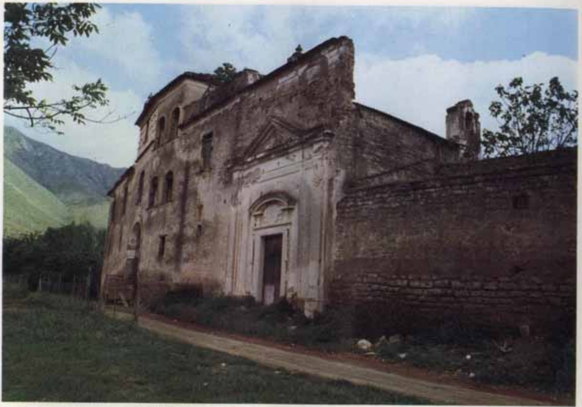
Fot. 19. - Masseria Schettini a San Prisco . Grande costruzione extraurbana del XVII secolo, con parco giardino, legata allo sfruttamento fondiario (seminativi). La costruzione, a semicerchio ed a tre livelli con alto muro di cinta, con giardino posteriore, piccionaia e cappella, risulta oggi disabitata ed in cattivo stato di conservazione.
