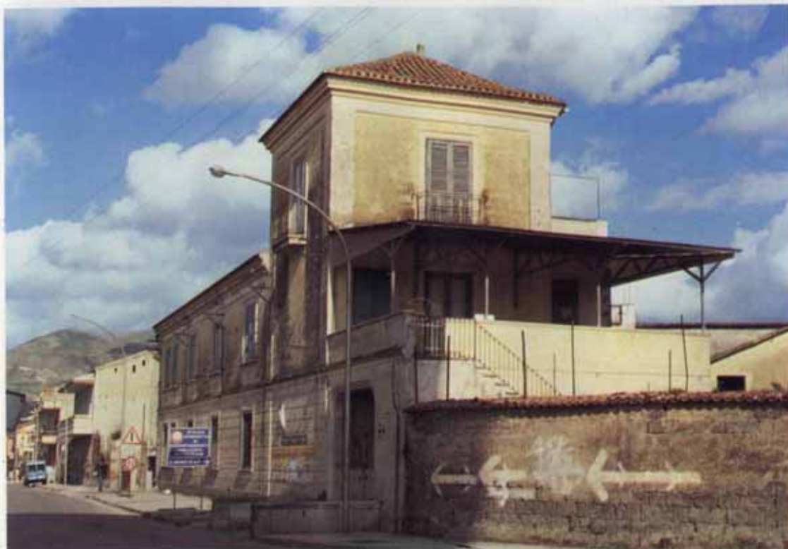
Fot. 24. - Masseria Puchetti a Triflisco (frazione di Bellona) . L'edificio, del XVII secolo, con cappella annessa, è in corso di ristrutturazione. Sorto a scopo agricolo-residenziale in zona pianeggiante, era annesso a un fondo a colture legnose. Strutturato su due livelli, con scantinati adibiti a cantine, ha esaurito la sua funzione originaria ed è utilizzato come residenza stabile non rurale.
