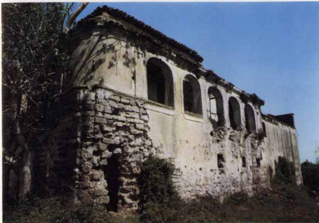
Fot. 22. - Masseria Angelillo a Carinola . Edificata in zona pianeggiante nel XVIII secolo, con funzione agricolo-residenziale, la masseria, oggi disabitata e di grandi dimensioni, con ampio giardino, era legata allo sfruttamento fondiario (colture seminate) e possedeva vari servizi rurali. Strutturata su due livelli e con una forma a blocco, è in pessimo stato di conservazione e non ha subito alcuna trasformazione. La presenza di una cappella, affrescata all'interno con un quadro di Santa Lucia opera di Salvator Rosa, e l'estensione del fondo annesso (900 moggi) dimostrano l'importanza di questa costruzione i cui proprietari non volevano certo privarsi degli agi che le fiorenti condizioni economiche permettevano loro. Ciò è avvalorato anche dalla leggenda di un tesoro custodito nelle fondamenta dell'edificio, per la ricerca del quale ignoti hanno praticato un grande squarcio nella parete anteriore.
