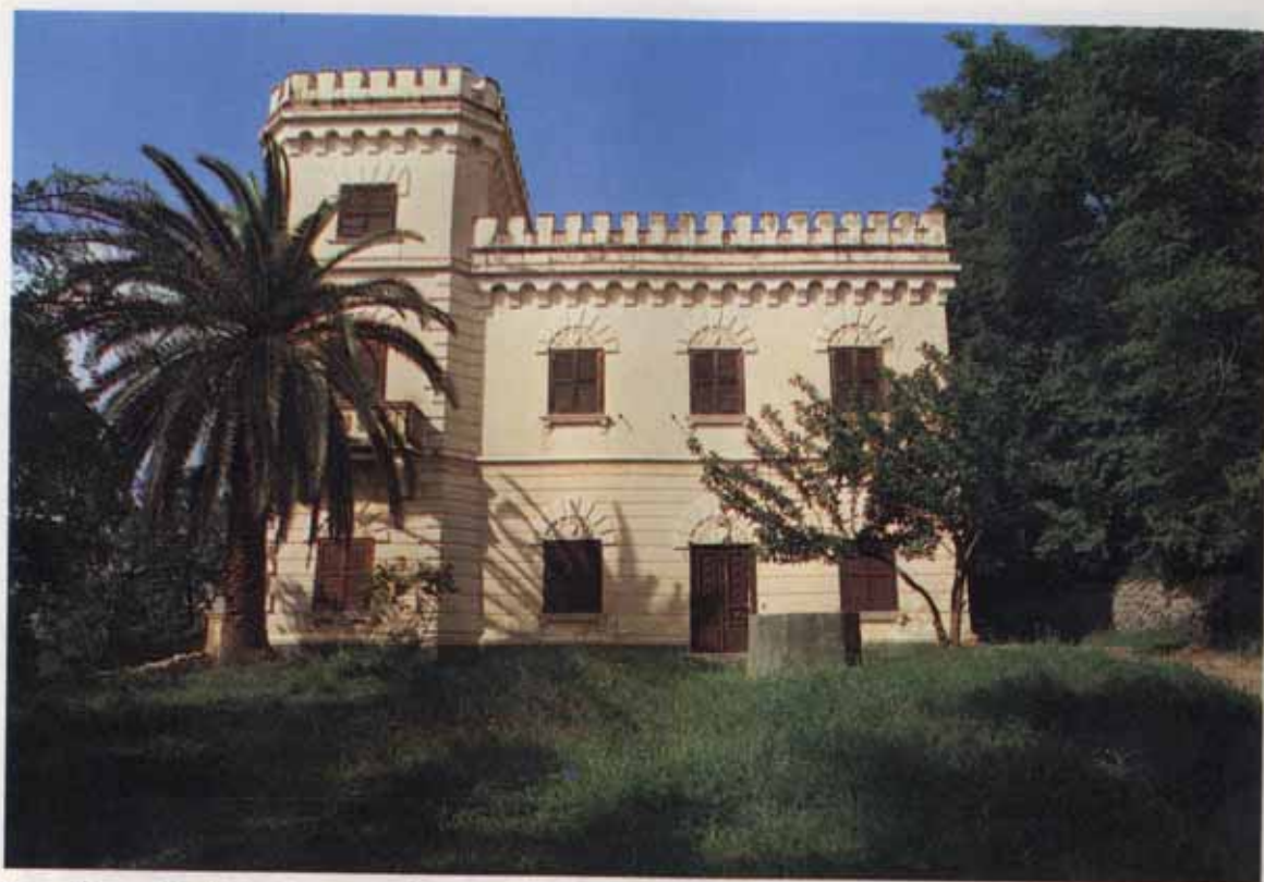
Fot. 33. - Casino Verno nella frazione Della Corte (comune di Rocca d'Evandro). Edificio extraurbano di modeste dimensioni del XIX secolo, con giardino. Legato allo sfruttamento fondiario e completamente restaurato, è in buono stato di conservazione e presenta una struttura a blocco su due livelli con torretta laterale di tre piani, sormontata da un belvedere. Un tempo assolveva ad una funzione agricolo-residenziale, in quanto il fondo annesso era in parte utilizzato per le colture seminative ed in parte per prati, pascoli e boschi, mentre oggi costituisce solo residenza non agricola, per cui i servizi rurali sono stati destinati ad altro uso.
