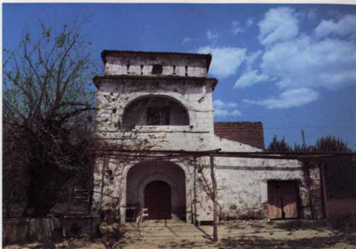
Fot. 25. - Masseria Spano a Falciano del Massico . Caratteristico edificio extraurbano del XVIII secolo di modeste dimensioni, con piccolo giardino ed alcuni servizi rurali (colture legnose). La masseria, sita in pianura ed utilizzata per scopi agricolo-residenziali, ha una forma a blocco, una scala esterna per l'accesso ad una loggia, la colombaia; è in cattivo stato di conservazione e disabitata.
