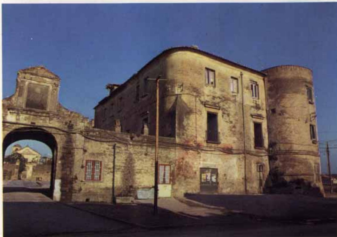
Fot. 49. - Castello di Lorianò a Marcianise . Solo in parte abitato, costruito nel XVI secolo, è in discreto stato di conservazione. Sorto con funzione agricolo-residenziale e situato in una pianura a seminativo, si presenta a due o a tre livelli con torrioni laterali ed è dotato di cantina, di depositi per prodotti ed attrezzi vari, di stalla e di cappella. Se il carattere edilizio originario, a semicerchio, non è stato alterato nel corso dei secoli, la sua struttura ha subito modifiche per l'aggiunta di corpi di fabbrica e parziali ristrutturazioni.
