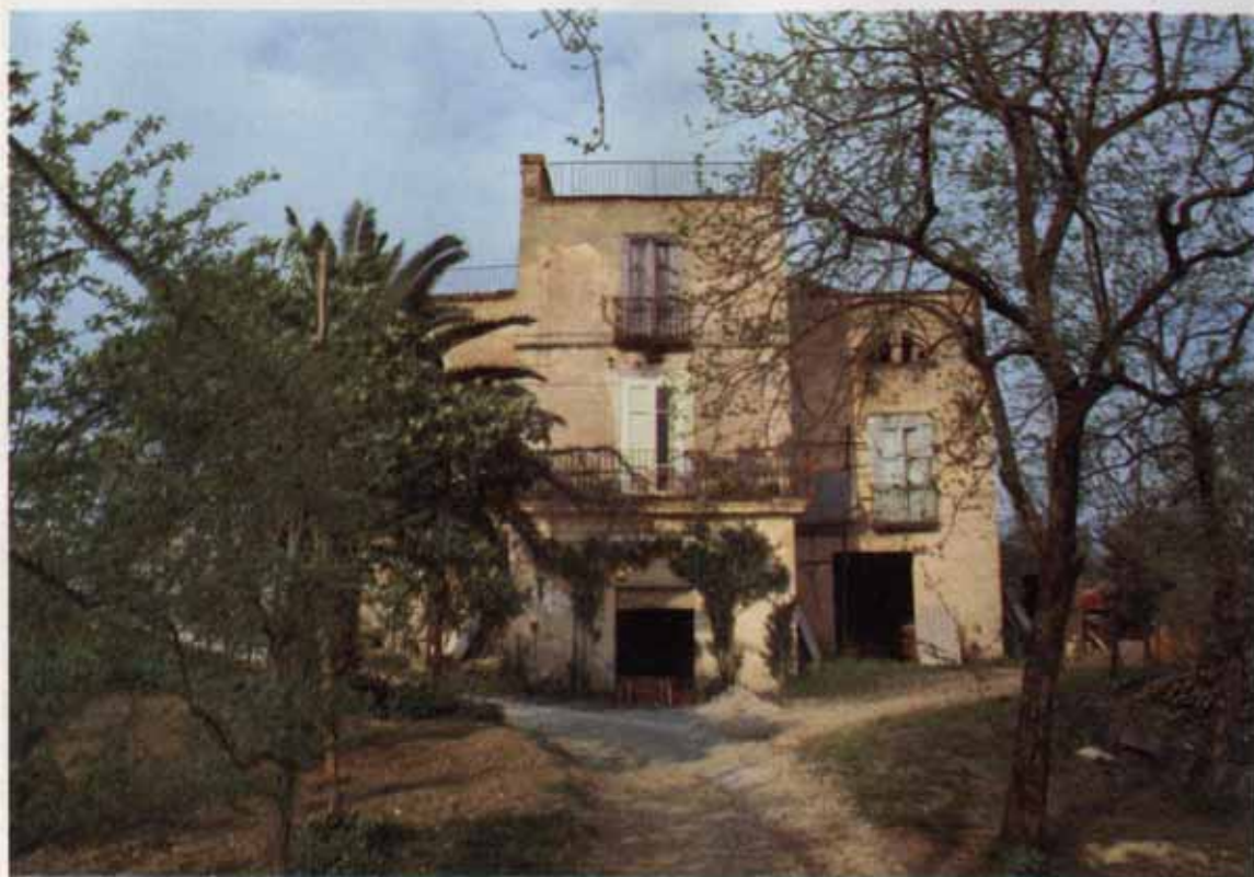
Fot. 43. - Casino Pezzullo a Teano . L'edificio, medio collinare e su tre livelli, pur realizzato in periodi diversi, è comunque attribuibile al XIX secolo; presenta una forma a blocco con tetto a terrazzo ed è in discreto stato di conservazione. Originariamente, per il fondo annesso a colture legnose, aveva funzione agricolo-residenziale, per cui era fornito di depositi per prodotti ed attrezzi vari; oggi, parzialmente ristrutturato, è residenza non agricola.
