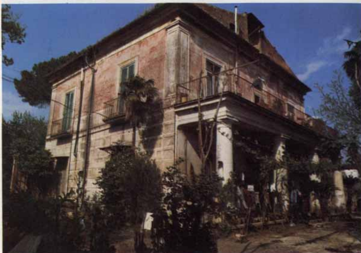
Fot. 28. - Masseria Pappabove a Versano (frazione di Teano) . Costruita nel XVIII secolo ed appartenente alla famiglia Piscicelli, è legata allo sfruttamento fondiario (colture legnose) ed è posta in zona collinare. In cattivo stato di conservazione, presenta una pianta ad L ed è strutturata su due livelli con sottotetto. Sorta con funzione agricolo-residenziale, nonostante i lavori di ristrutturazione parziale, oggi è disabitata.
