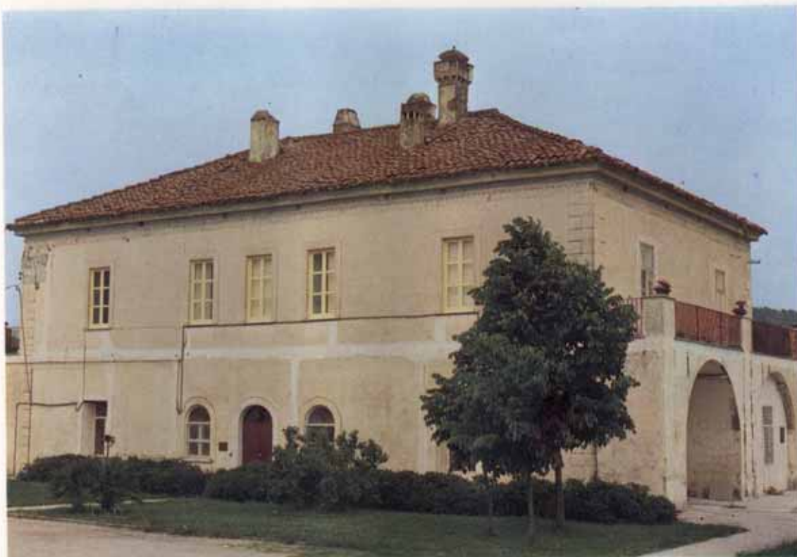
Fot. 34. - La Reale Fagianeria a Piana di Monte Verna . Ex-tenuta di caccia dei Borboni, il casino, costruito nel XVIII secolo, è in buono stato di conservazione e non ha subito alcuna trasformazione nel tempo. Infatti esso conserva la sua forma a blocco, strutturata su due livelli: sul primo insistevano un salone, la cucina e gli ambienti per la servitù, sul secondo le camere padronali. Il terreno intorno, pianeggiante e ricco di boschi, costeggiato dalla strada borbonica Napoli-Venafro, accoglieva fagiani (anche allevati), lepri e cinghiali. Le bonifiche ed il diboscamento hanno alterato l'habitat naturale favorendo la diffusione delle colture seminative e seminative irrigue. Di stile vanvitelliano, presenta un ampio terrazzo laterale sorretto da archi e servizi rurali, mentre sul lato meridionale vi era un ricovero per cani da caccia. Una volta residenza saltuaria, oggi è sede del Centro di Ricerca Agro-Industriale (C.R.A.I.) ed è inserita in un complesso zootecnico di ampie dimensioni.
