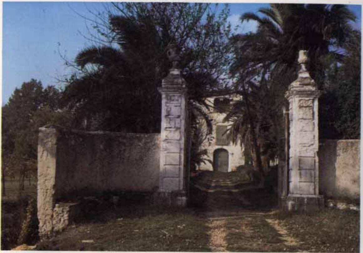
Fot. 32. - Casino Ventriglia a Piedimonte Matese . Sorge al centro di un podere lambito dal Vallone Paterno. L'edificio, con forma a blocco e costruito nel XIX secolo, è in cattivo stato di conservazione e disabitato. Un tempo aveva funzione agricolo-residenziale e presenta il granaio, la stalla, la cantina ed ampi depositi destinati ad accogliere i prodotti delle colture seminate e legnose. Strutturato su due livelli, con corpi di fabbrica aggiunti sul lato posteriore, possiede al centro un belvedere coperto.
