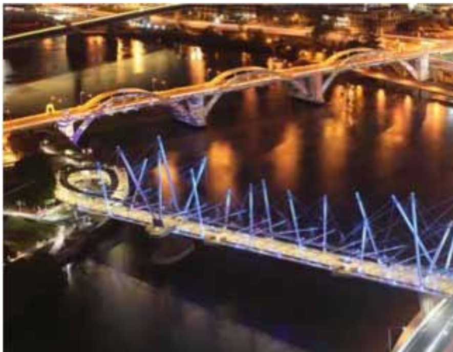
Fig. 10 - Il ponte ciclo-pedonale Kuripla (Brisbane), auto-illuminato grazie ai suoi pannelli fotovoltaici
