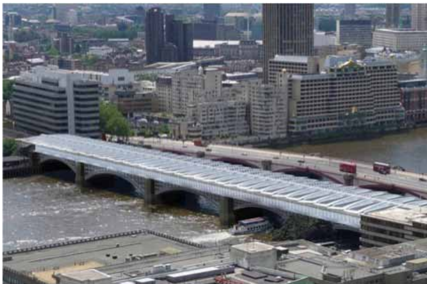
Fig. 9 - Il restyling del Blackfriars di Londra con l'installazione dei moduli fotovoltaici
