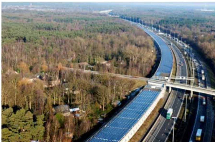
Fig. 12 - Copertura della linea ferroviaria Belga per mezzo di fotovoltaico integrato nella struttura
