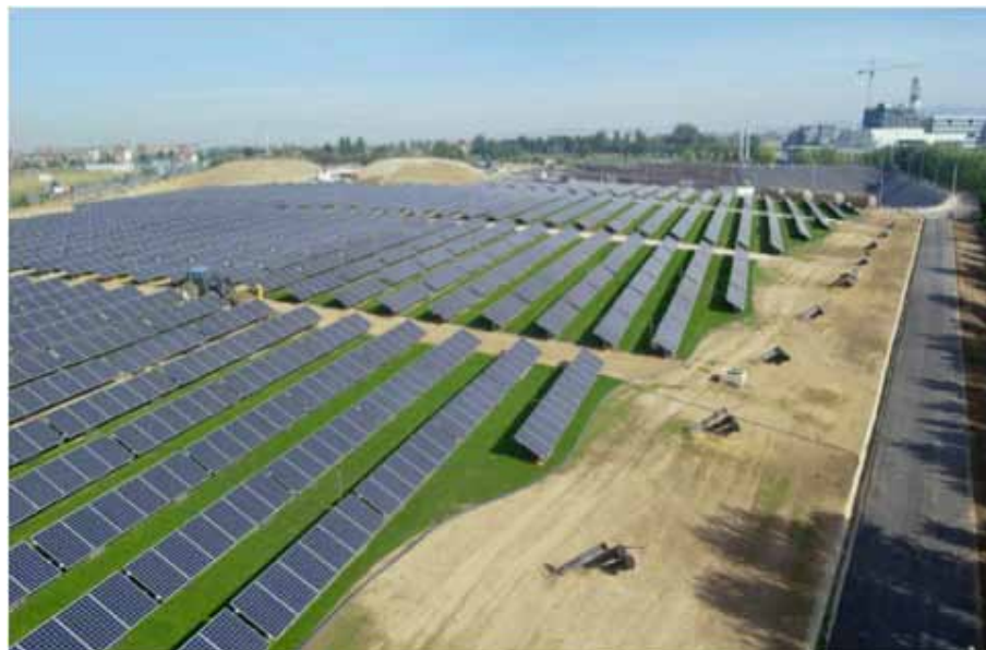
Fig. 13 - Il parco fotovoltaico nell'ex discarica di Collegno (Torino)
