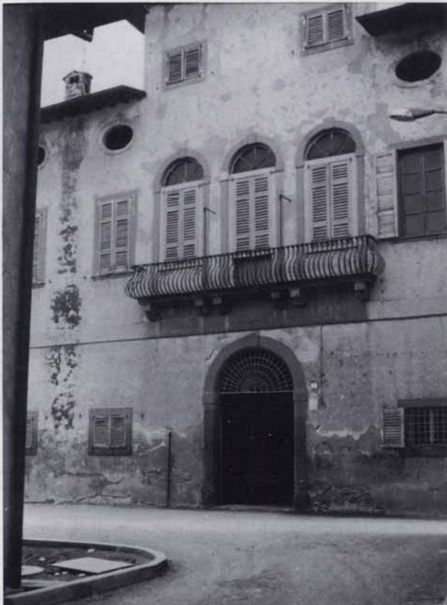
Fig. 9 - Passo carrabile del Palazzo Giovanelli dalla « Contrada Castello » (Fig. 20) e dai giardini padronali (Fig. 21), come si presentano oggi. Osservando le due figure, possiamo notare come il lato orientale del Palazzo (Fig. 21) sia meglio rifinito nei suoi vari elementi: la volta ed i pilastri della porta più ricchi, le finestre a piano terra più grandi, la balconata in pietra (mentre l'altra è lavorata in ferro battuto), le finestrelle ovali sottolineate da uno zoccolo in rilievo ecc. Tutto ciò fa supporre che fosse questa la facciata principale del Palazzo Giovanelli.
