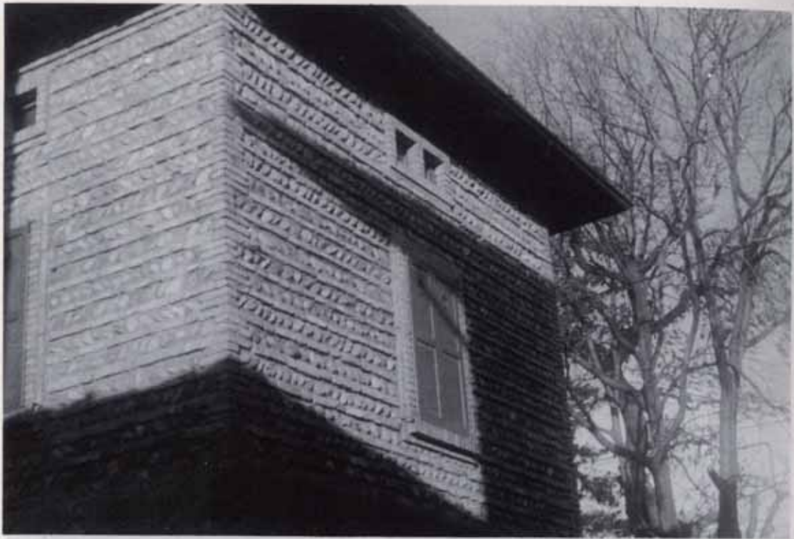
Fig. 12 - Il lato occidentale dell'edificio della prigione come appare oggi. Forse, originariamente, essa aveva l'ingresso sul lato opposto, arricchito da un arco tutto-ora esistente. Il rivestimento esterno delle pareti, composto da mattoni e pietre di fiume disposte a lisca di pesce cordonata, ci richiama alle tecniche ed ai materiali usati per le costruzioni, nel Sei-Settecento, nei centri rurali della pianura bergamasca. Stessa lavorazione ritroviamo ancora in tutti gli edifici esistenti a Morengo, risalenti al periodo settecentesco.
