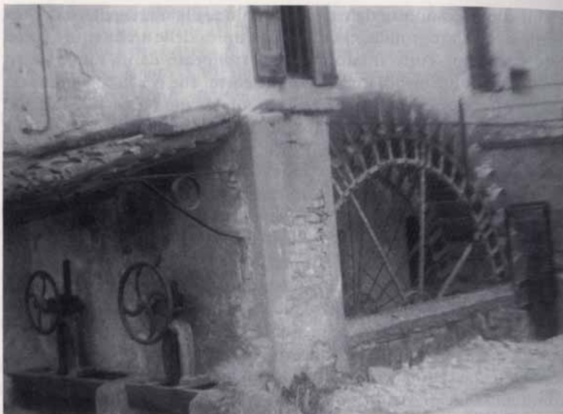
Fig. 15 - Il Molino di Ger, di proprietà della Mensa Vescovile. L'acqua veniva regolata da chiuse ben visibili in primo piano, che mettevano in funzione la ruota.
