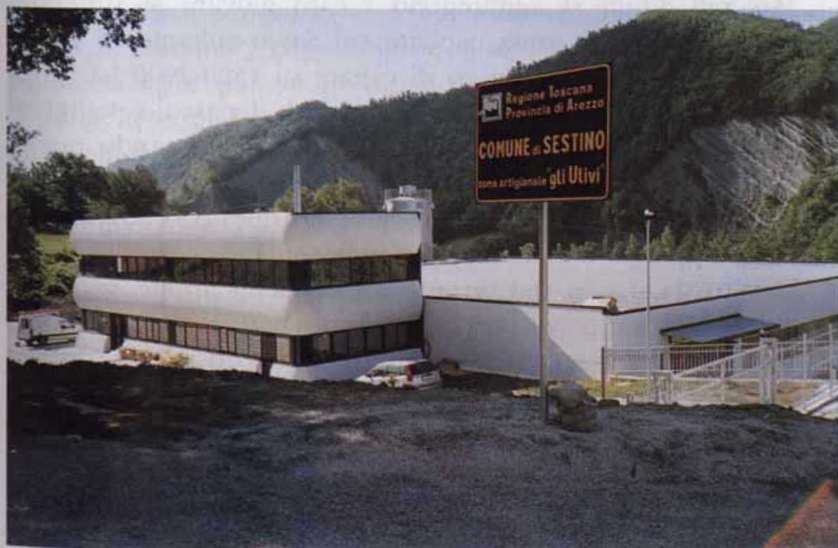
Fig. 23 - Sestino: zona artigianale "gli Ulivi" con l'impianto del Mobilificio Fogliense.
