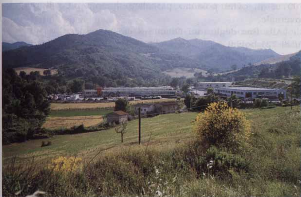
Fig. 22 - Sestino: zona artigianale di Piego con gli impianti del Gruppo Centraltubi.
