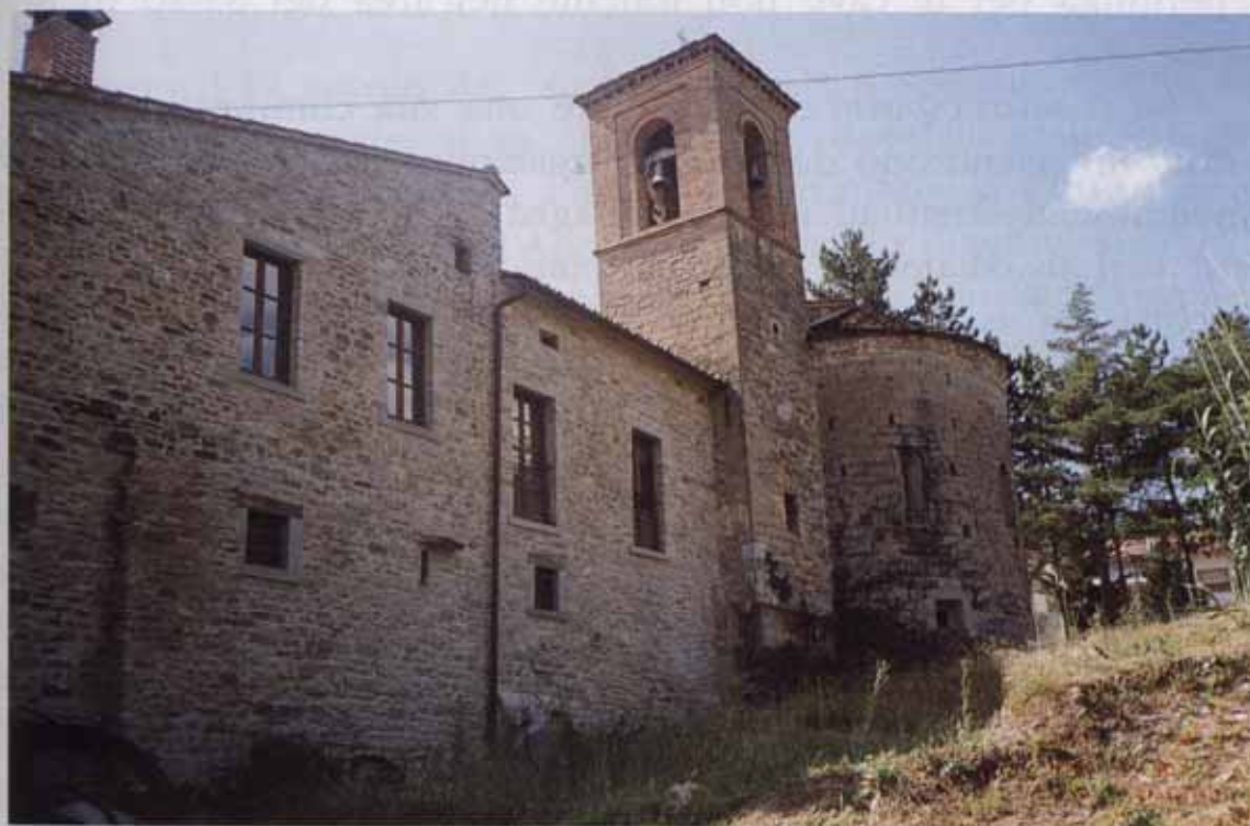
Fig. 5 - Sestino: Chiesa di San Pancrazio, l'abside, il campanile e la canonica.
