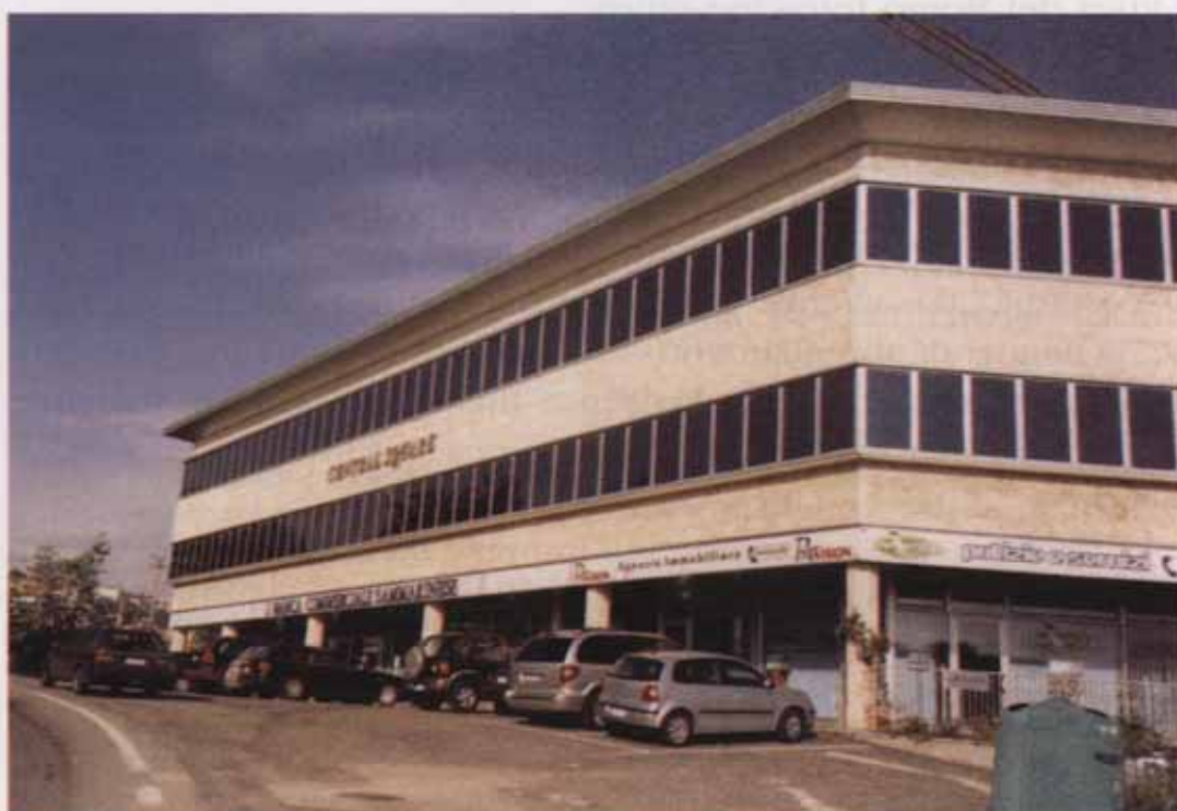
Fig. 13 - Domagnano di San Marino: centro commerciale Central Square.
