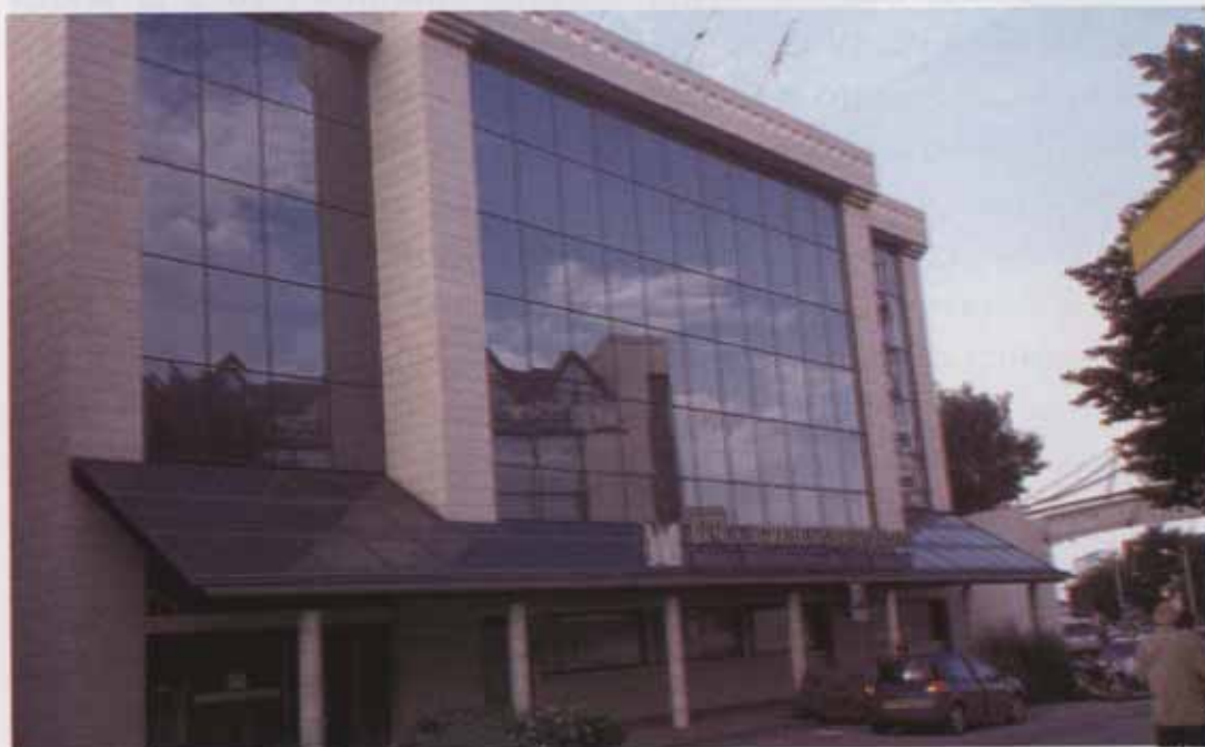
Fig. 10 - Dogana di San Marino: Direzione Generale della Banca Agricola Commerciale.
