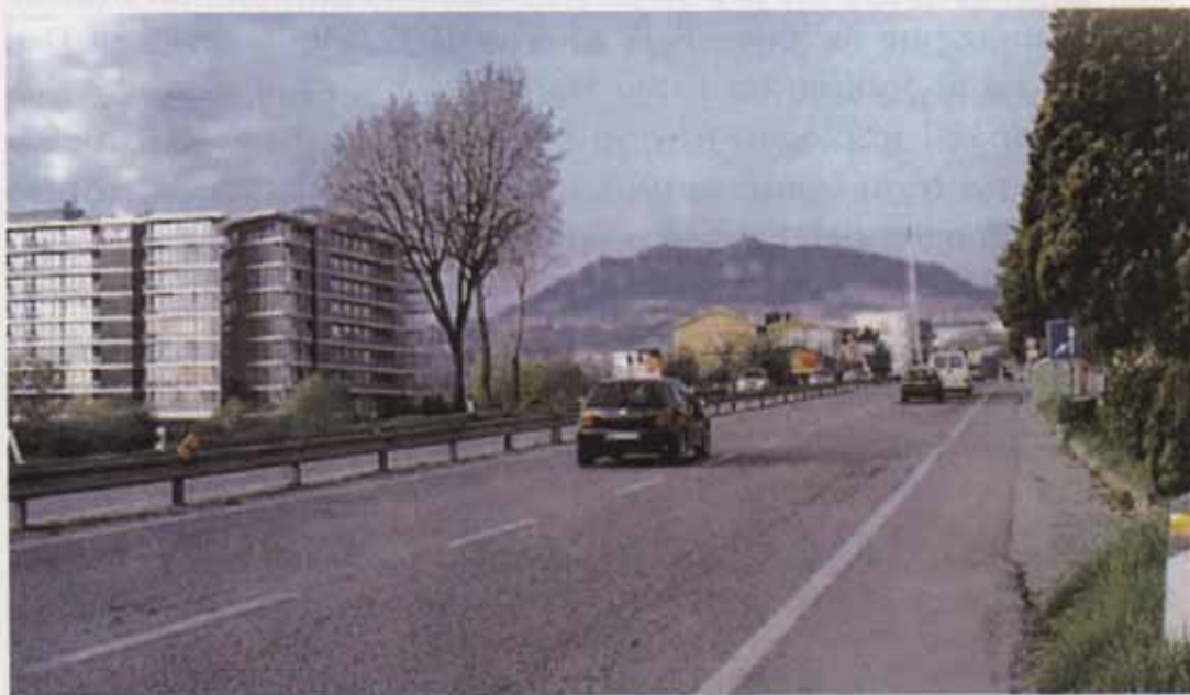
Fig. 2 - La superstrada oggi, con l'espansione edilizia di Borgo Maggiore e lungo la base del Titano.
