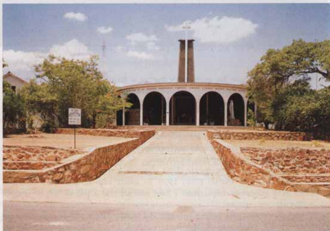
Fig. 34 - Kariba: chiesa di Santa Barbara, che ricorda gli operai italiani morti durante la costruzione della diga.
