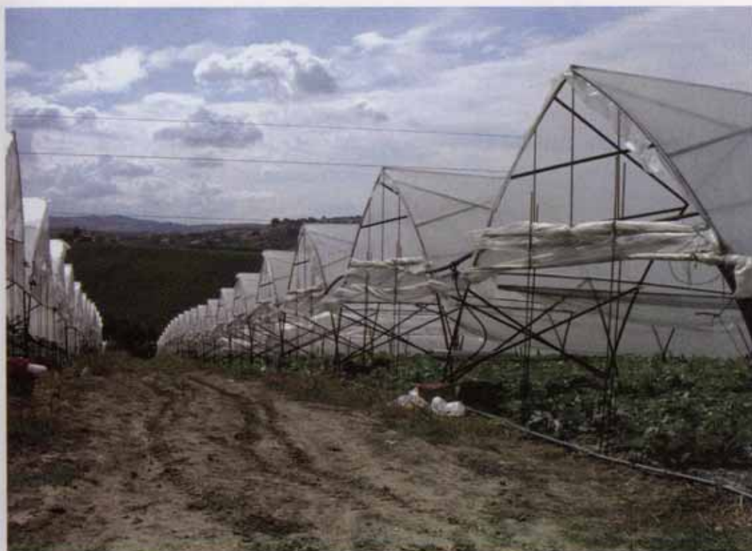
Fig. 13 - Coriano, frazione di Cerasolo: serre per ortaggi di Edgardo Astolfi.
