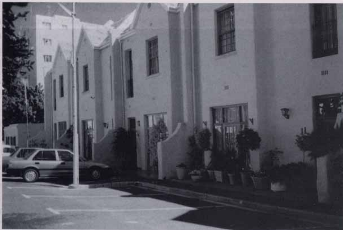
Fig. 26 - Città del Capo, antiche case dei pescatori italiani, oggi completamente ristrutturate e divenute area residenziale.
