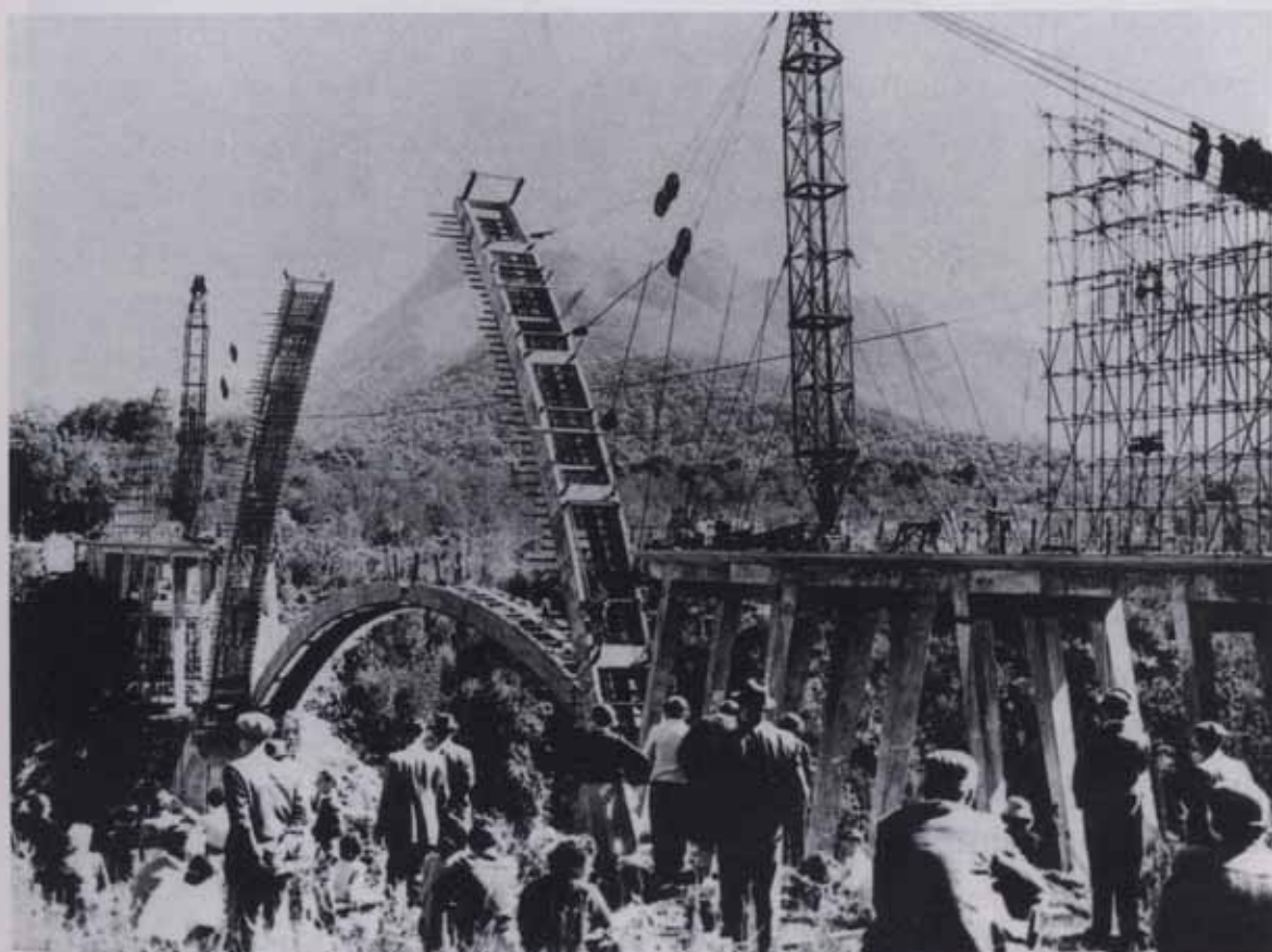
Fig. 30 - Provincia del Capo, 1956, costruzione del ponte sullo Stormriver tra Port Elizabeth e Knysna, una delle maggiori opere della Concor Construction .
