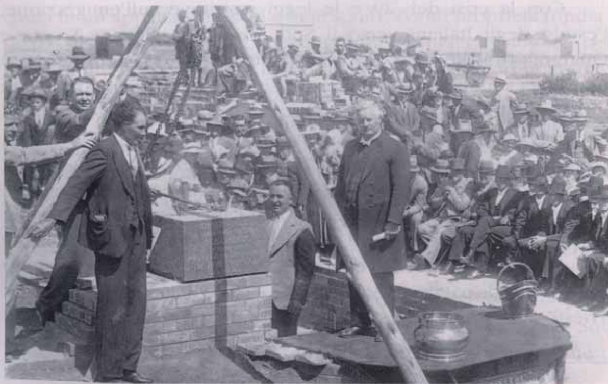
Fig. 11 - Pretoria, posa della prima pietra del Voortrekker Monument (impresa A. Cossani, Builder & Contractor ), 1938.
