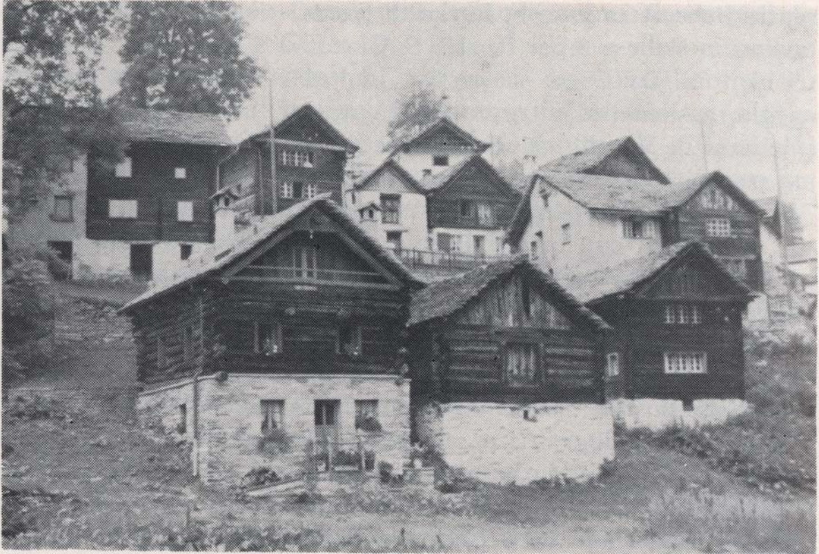
Case di Bosco Gurin, che ricordano quelle in legno di origine tedesca e quelle in pietra di tradizione sub-alpina. I tetti sono in piode di gneiss.
