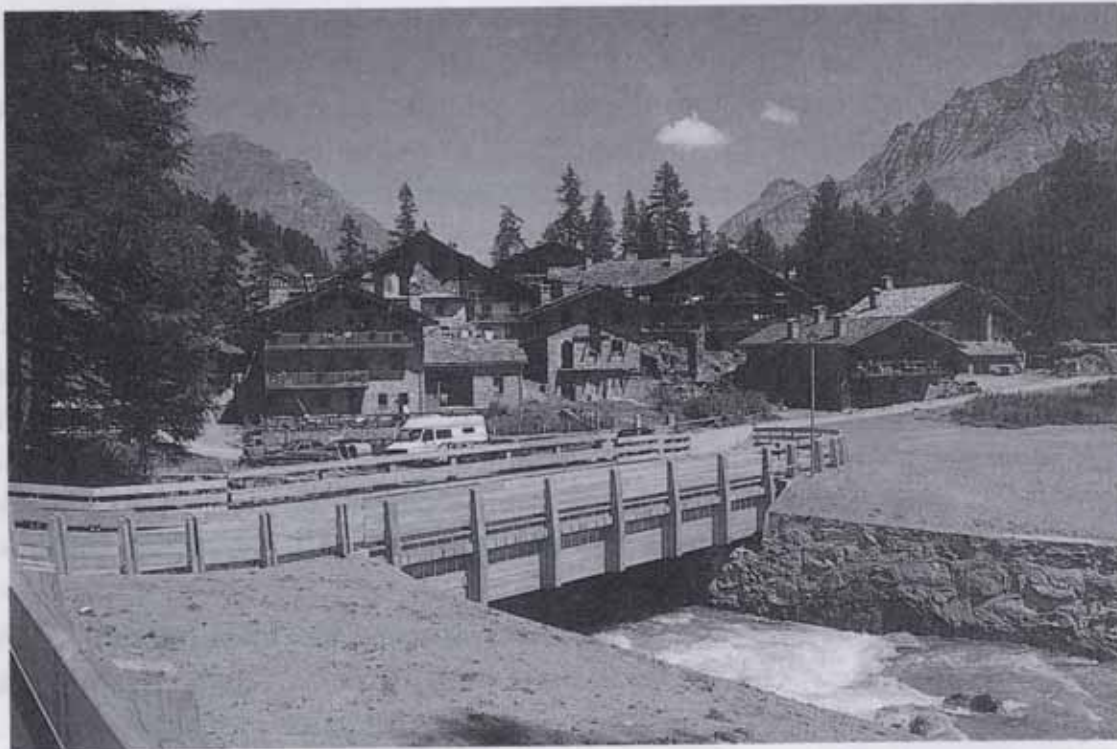
Fig. 5 - Il villaggio di Pellaud nel comune di Rhêmes-Notre-Dame (Valle d'Aosta): la ristrutturazione delle vecchie abitazioni è stata quasi ultimata, rispettandone lo stile tradizionale.
