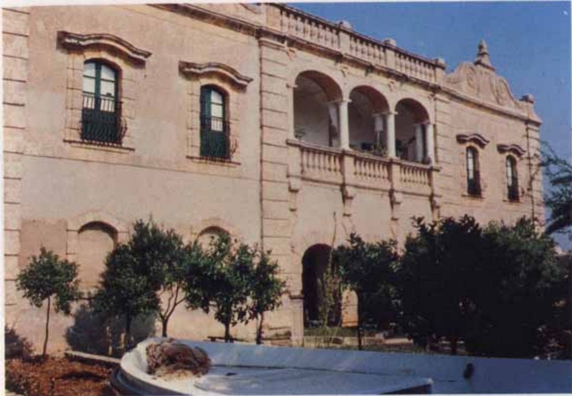
Fot. 30 - Villa Eleonora . Il prospetto secondario, a due elevazioni con una raffinata loggia trifora nella parte centrale, è rivolto verso il mare e si affaccia su un giardino di fiori recintato da un alto muro a cui è addossata una torretta belvedere, presente anche in altre dimore di campagna settecentesche.
