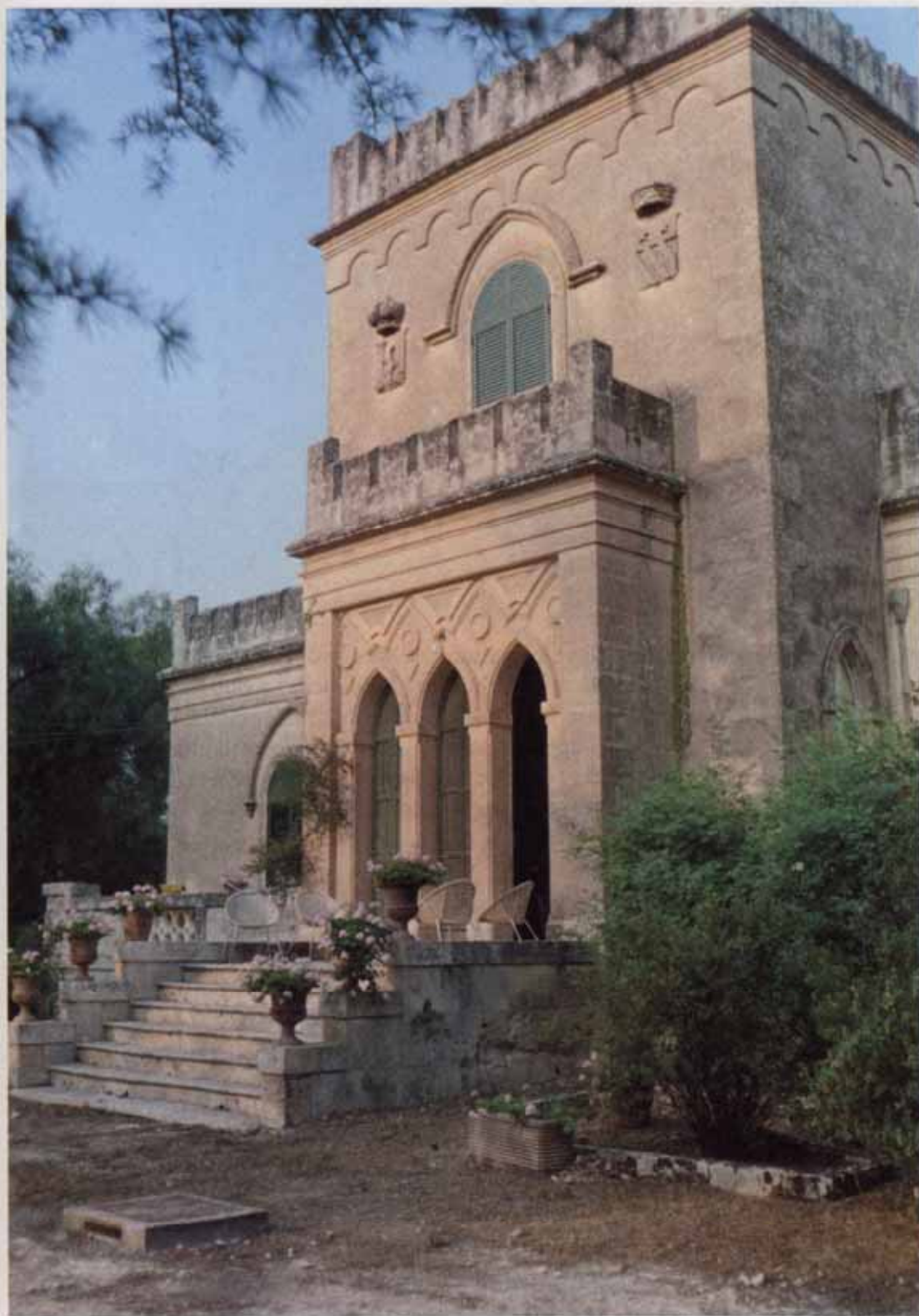
Fot. 49 - Villa del Principe Nicolaci di Villadorata . Sul prospetto anteriore della dimora gli stemmi della famiglia Nicolaci. Lo stile della costruzione, con merlature nel cornicione ed aperture ogivali, fu ripreso in altre case di villeggiatura della stessa area. Immersa in una ombrosa pineta, è tuttora usata dai proprietari d'estate, per la villeggiatura.
