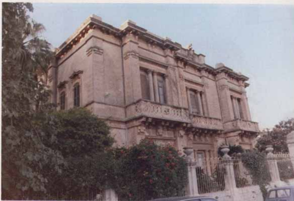
Fot. 41 - Villa Arezzo . Il prospetto posteriore è a due elevazioni e si affaccia sulla vallata sottostante. Molto ricercate le decorazioni dei balconi di pietra lavorata. La villa, edificata su progetto di un allievo del Basile, è abitata stabilmente.
