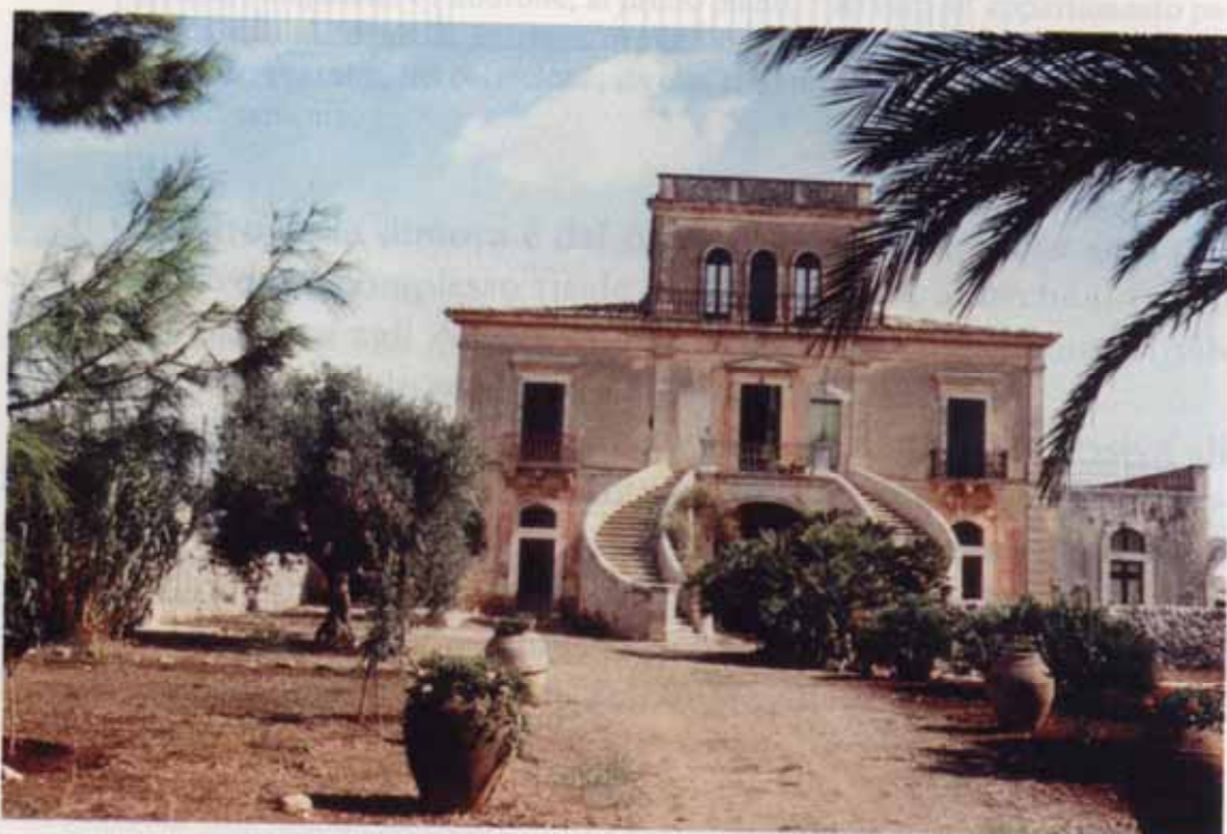
Fot. 55 - Villa Nicastro . Elegante costruzione del Ragusano a due elevazioni, con impianto a blocco; nella parte centrale si erge una loggia con tre aperture ed un originale scalone doppio che conduce al piano superiore e movimentata la struttura conferendole leggerezza.
