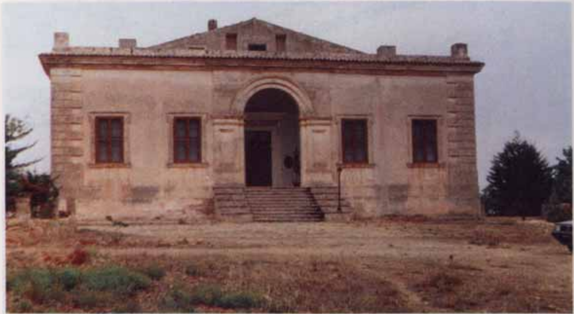
Fot. 31 - Villa S. Alfano . Residenza di campagna di una nobile famiglia di Noto, risale al XIX secolo ed è sita sulla cimosa costiera, in un'area destinata alla mandorlicoltura; è ad una sola elevazione, con una parte seminterrata riservata ai servizi. Il prospetto principale, piuttosto semplice, è ornato da conci angolari e da una scala che conduce ad un piccolo androne. Lo spazio antistante alla casa, acciottolato con pietre di fiume, è limitato da edifici rurali, posti di fronte.
