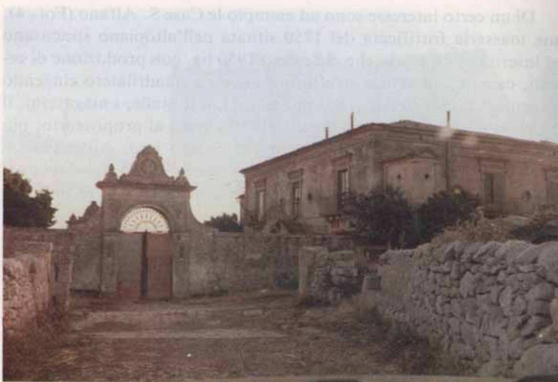
Fot. 5 - Villa Tresauro . Situata sull'altopiano ragusano a circa 600 m di altitudine, in un'area destinata prevalentemente all'allevamento bovino. Risale alla metà dell'Ottocento e fu edificata con funzione agricolo-residenziale. La dimora del proprietario, a due livelli, è separata dalla corte rurale che è situata di fronte. Le due costruzioni sono cinte da un alto muro, interrotto da due eleganti portali.
