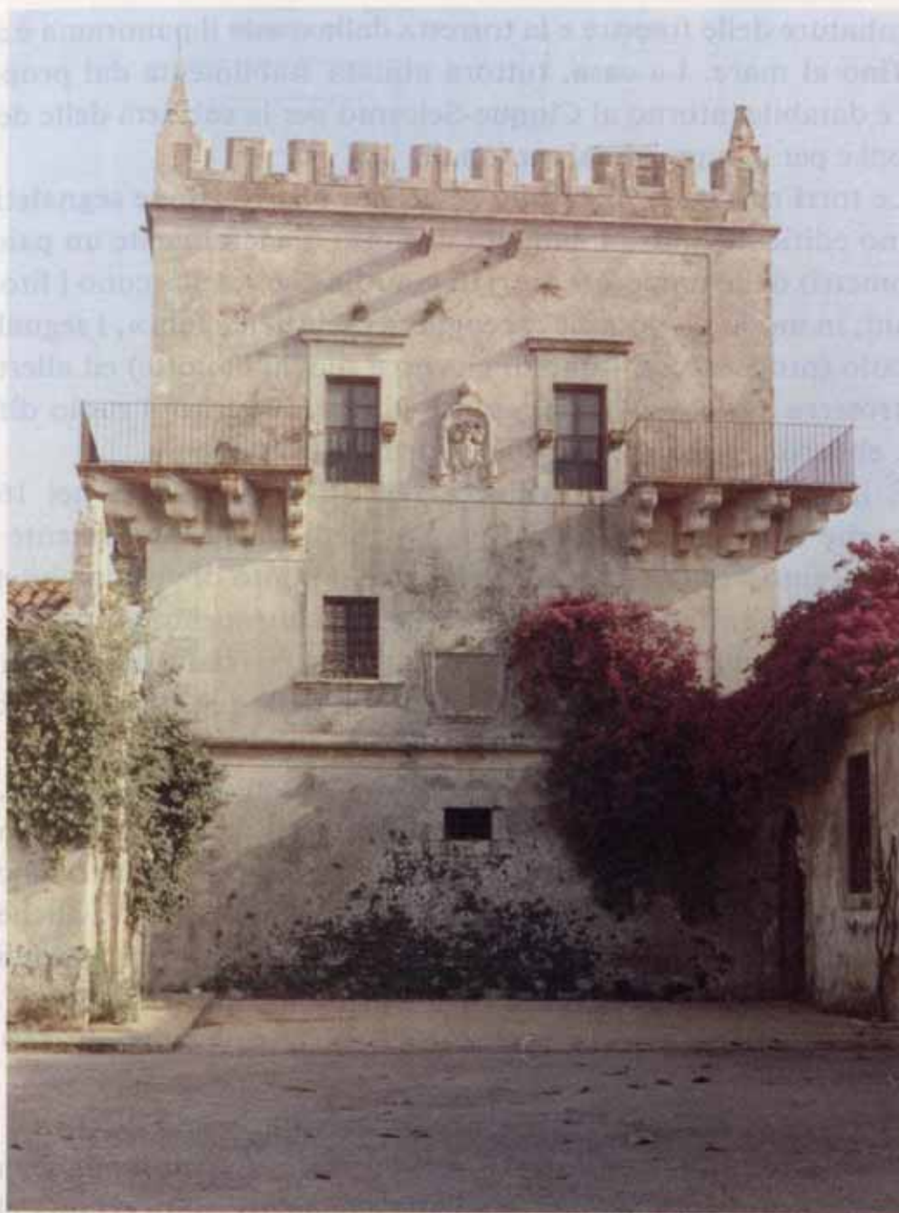
Fot. 22 - Torre Milocca . Torre di guardia rusticana, edificata alla periferia sud di Siracusa alla fine del Seicento, in sostituzione di quella preesistente quattrocentesca, distrutta dal terremoto, di cui ripropone lo schema compositivo. È a tre elevazioni ed ha impianto cubico; le aperture al pianterreno sono solo delle feritoie, mentre al primo piano presentano le caratteristiche strombature. Molto eleganti i balconi agli angoli del secondo piano, sorretti da mensoloni lavorati. Della struttura quattrocentesca rimangono una scaletta esterna di pietra che, con un piccolo ponte levatoio, portava al piano superiore e, inoltre, i resti di quattro torrette cilindriche e di un muro di cinta che proteggevano il complesso. Esaurito il suo ruolo difensivo, la torre, riattata all'interno, è usata come residenza stagionale.
