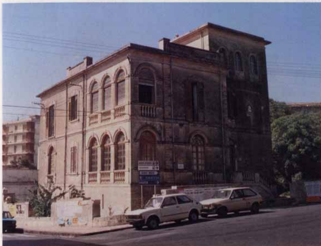
Fot. 38 - Villino Gallo . Gradevole villino alla periferia di Noto in prossimità della «Flora», i giardini pubblici della città. La costruzione è formata da due corpi di dimensioni diverse: quello più vasto, a due livelli, presenta una loggia vetrata angolare ai due piani, mentre il corpo più piccolo, a tre elevazioni, è simile ad una torre, con aperture semplici. Sul lato destro della casa un giardino ormai incolto. Oggi la villa ospita una comunità assistenziale.
