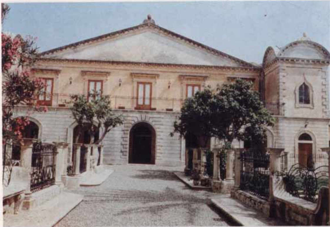
Fot. 17 - Villa Bibbia . Elegante dimora di campagna dell'altopiano siracusano, a 500 m di altitudine: è a due elevazioni e presenta due avancorpi ai lati della balconata che corre lungo la facciata. Caratteristiche dello stile eclettico le decorazioni, ora in stile neoclassico, ora neogotico. Eleganti anche gli ornamenti in forma di pigna, al centro del cornicione e sugli avancorpi. Nella parte anteriore della villa un piccolo giardino di fiori, ornato da panchine di pietra lavorata. La vasta e composita corte rurale si snoda ai lati e sul retro.
