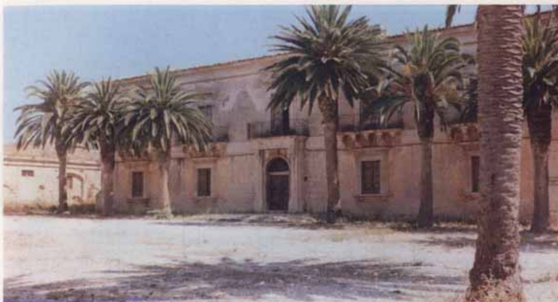
Fot. 33 - Villa Tedeschi . Elegante villa ottocentesca sita a Pozzallo in un'area un tempo periferica, ormai raggiunta dall'espansione del centro. È a due elevazioni e presenta una teoria di eleganti aperture simmetriche al piano superiore. Conduce alla villa un lungo viale, soffocato in parte dalle costruzioni recenti: molto elegante il portale d'ingresso in pietra incisa con eleganti decorazioni zoomorfe. Sul retro la vasta corte rurale, del tutto abbandonata.
