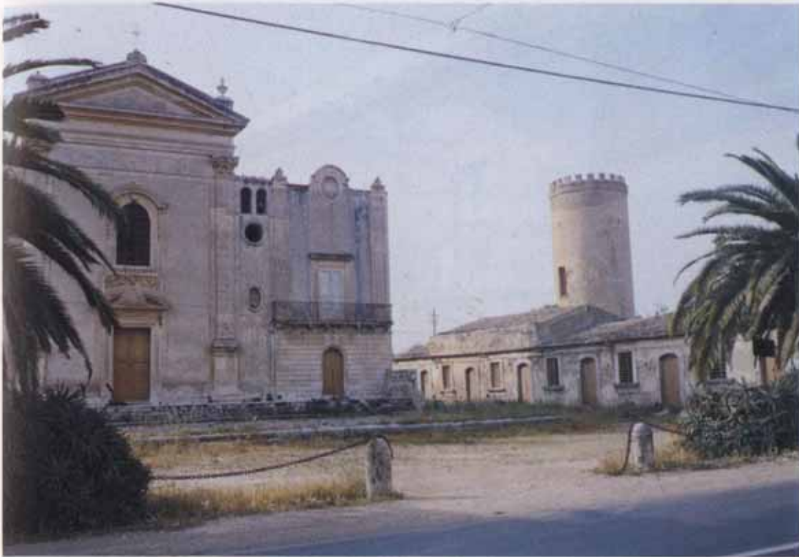
Fot. 27 - Il borgo rurale di Cassibile . Il piccolo borgo, oggi abbandonato, ad un chilometro dalla residenza padronale, fu creato dal Marchese per i suoi braccianti nella seconda metà dell'Ottocento: è formato da due file di abitazioni tutte uguali, con impianto unicellulare, situate ai lati della strada. Comprende anche la chiesa, la casa del sorvegliante, le carceri ed una piccola locanda, destinata ai braccianti reclutati solo occasionalmente nei periodi di raccolta.
