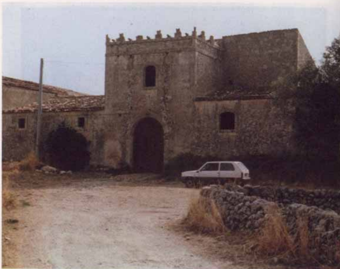
Fot. 4 - Case S. Alfano . Masseria edificata a metà del Settecento nell'altopiano siracusano, a circa 480 m di altitudine. La costruzione è inglobata in una recinzione muraria con la tipica torre per la vedetta sull'ingresso principale e due più piccole cilindriche agli angoli. Ad un solo livello i vari corpi di fabbrica che si aprono all'interno su un ampio cortile e comprendono le stalle, i magazzini, il frantoio e la cappella. A due livelli invece l'ala residenziale, curata anche nelle decorazioni interne. La masseria era inserita in un feudo assai vasto, destinato principalmente alla cerealicoltura, alle colture legnose asciutte e all'allevamento. Oggi, alienato il fondo, il complesso è semiabbandonato. Parzialmente in uso ancora le stalle e l'ala residenziale, abitata d'estate.
