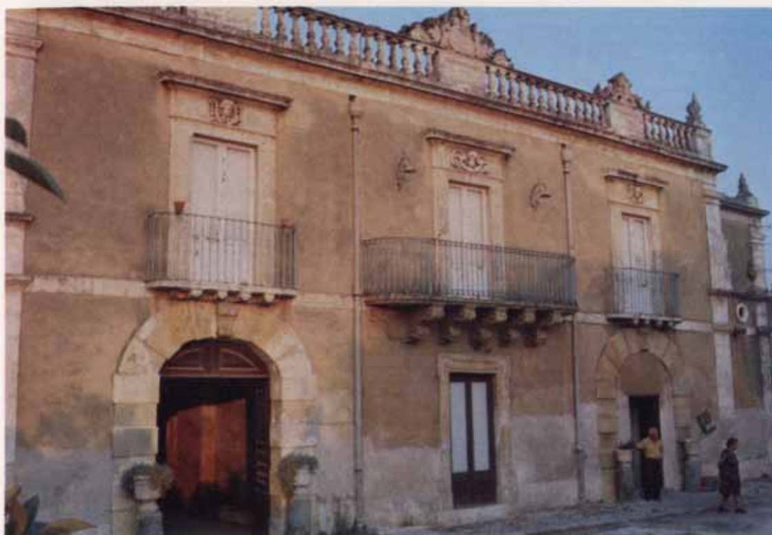
Fot. 44 - Villa Moscuza . Raffinata villa settecentesca alla periferia nord di Siracusa, sita in un'area destinata, fino agli inizi del secolo, alla villeggiatura ed ormai quasi completamente urbanizzata. La dimora è a due elevazioni e accoglie al pianterreno i locali per la servitù, la rimessa e l'androne che immette nel giardino posteriore, arricchito da panchine, vialetti, fontane e da una torretta belvedere. Il piano superiore della villa è riservato ai proprietari. Molto eleganti le decorazioni dei balconi, come pure raffinatissimo il cornicione a colonnine che culmina al centro in un elegante fastigio. Secondo studi recenti la dimora sarebbe stata edificata su progetto di Luciano Ali, un famoso architetto del XVIII secolo, autore del palazzo Beneventano del Bosco, a Siracusa.
