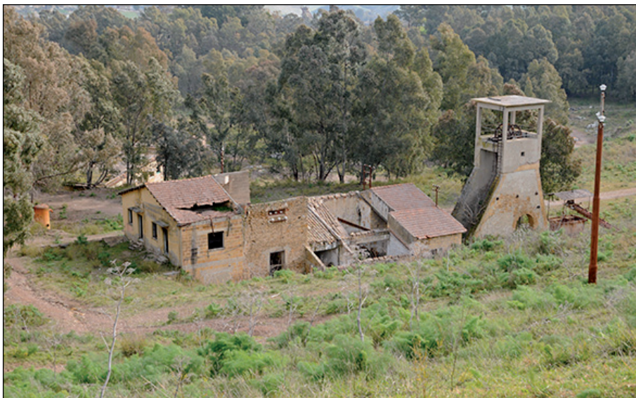
Fig. 3 - Miniera di Gessolungo, Caltanissetta
