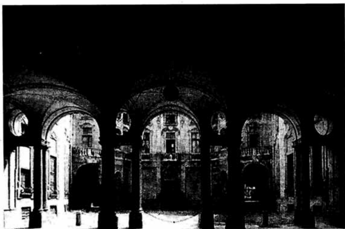
Fig. 7 - Casale: l'atrio e il cortile interno del settecentesco Palazzo Treville, oggi residenza privata.
