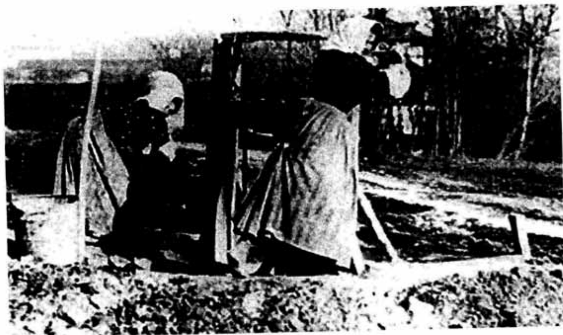
Fig. 10 - L'illustrazione, risalente al 1900, ritrae due donne all'esterno di un pozzo verticale, impegnate a manovrare manualmente i "verricelli" che consentivano di portare in superficie la marna estratta in profondità dai cavatori (Biblioteca Civica di Casale, fondo "F. Negri").
