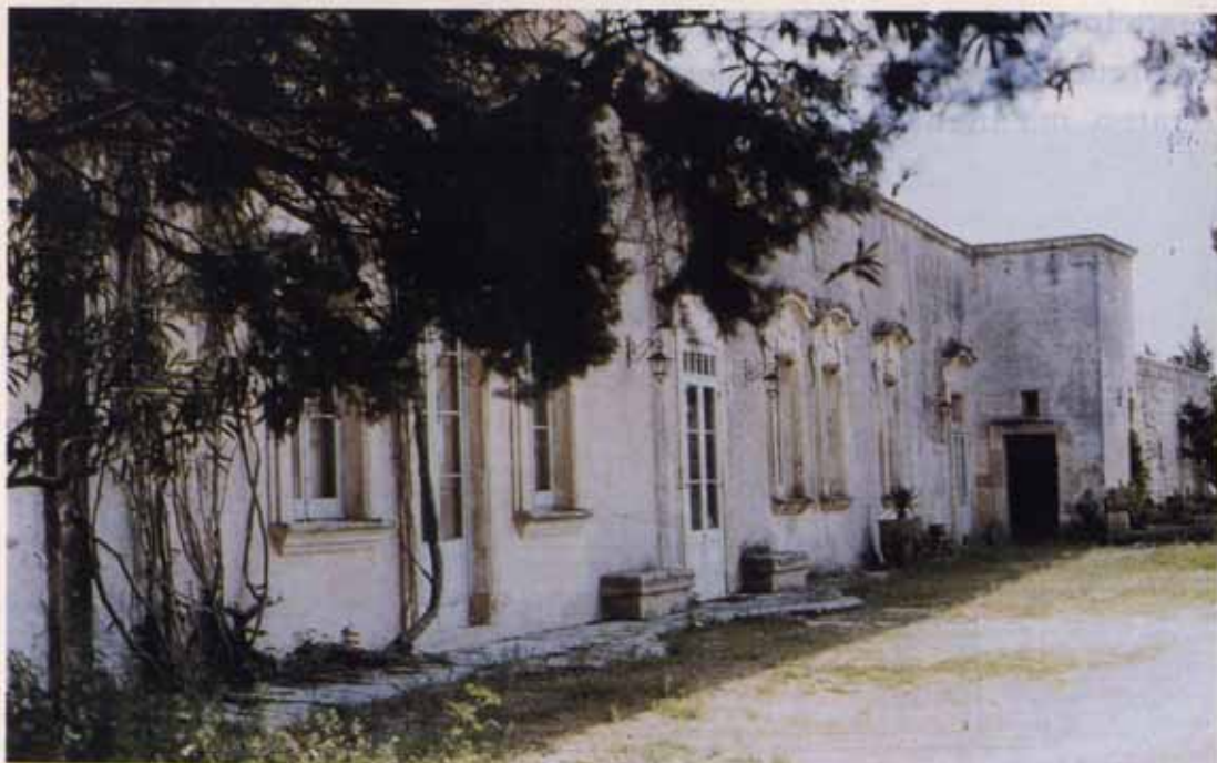
Fig. 10 - Villa Spada-Donateo (Lequile). Settecentesca costruzione, opera di Manuele Manieri, insigne architetto.
