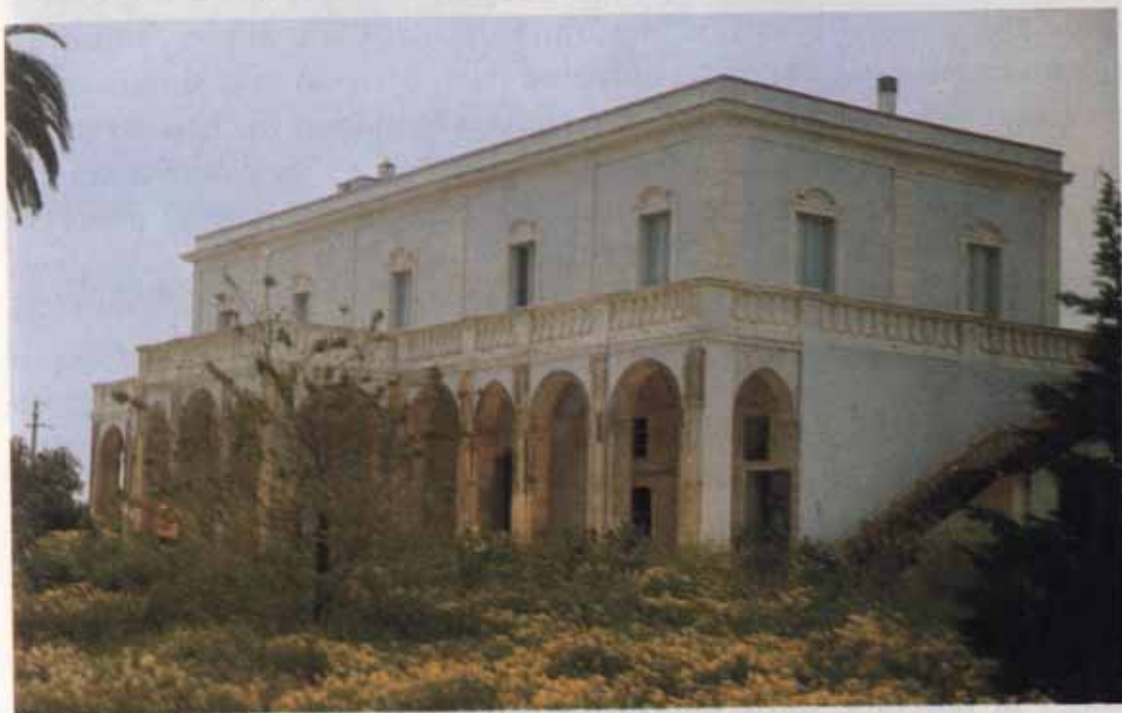
Fig. 12 - Villa Morea (Arnesano). Elegante costruzione, a due piani, è attualmente in restauro.
