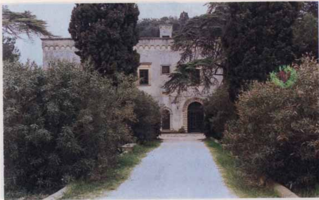
Fig. 13 - Casino Maggiulli (Lequile). Ottocentesca costruzione a due piani, in buono stato di conservazione, è abitato stabilmente.
