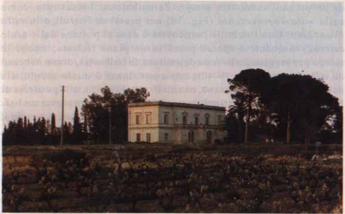
Fig. 38 - Villa Torrevecchia (Novoli). Sita nei pressi di Novoli, presenta una elegante facciata caratterizzata da un corpo avanzato a T, con leggiadre aperture in stile neogotico al pianterreno e sovrastata da un ampio balcone al piano nobile.
