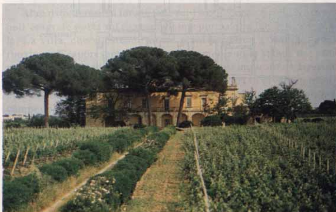
Fig. 11 - Casino Spada (Arnesano). Settecentesca costruzione ad impianto quadrangolare.
