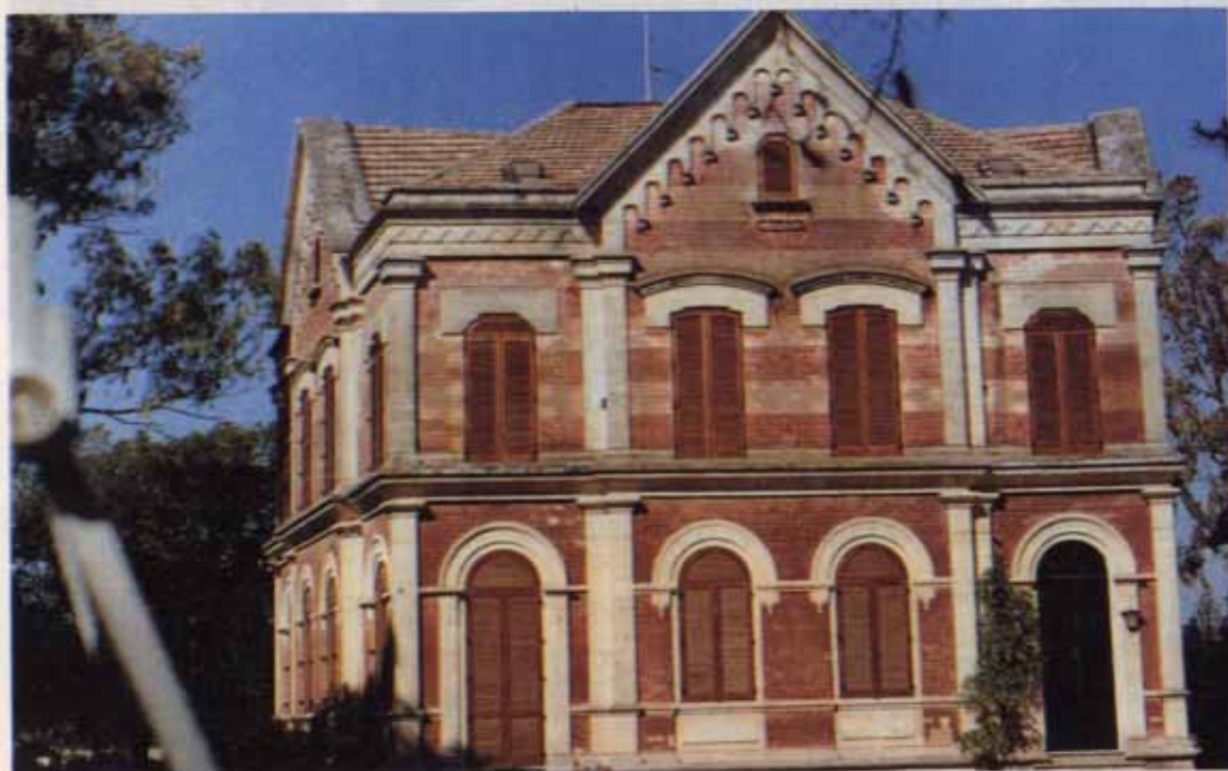
Fig. 31 - Villa Bodini (Lecce). Imponente costruzione a struttura cubica.
