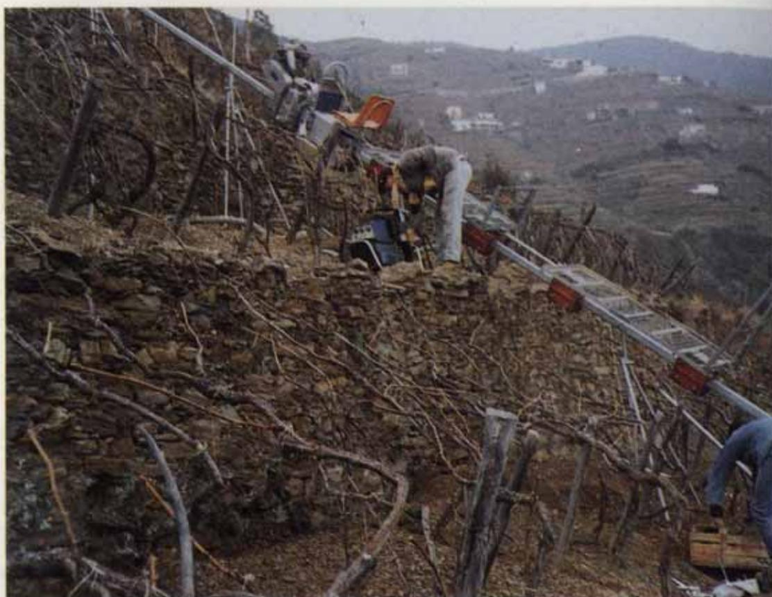
Fot. 24. - Cinque Terre. Sono in corso sui terrazzi, a vigneti in veste invernale, le operazioni di montaggio del trenino sulla monorotaia, già predisposta lungo il versante (foto Comunità Montana della Riviera Spezzina).
