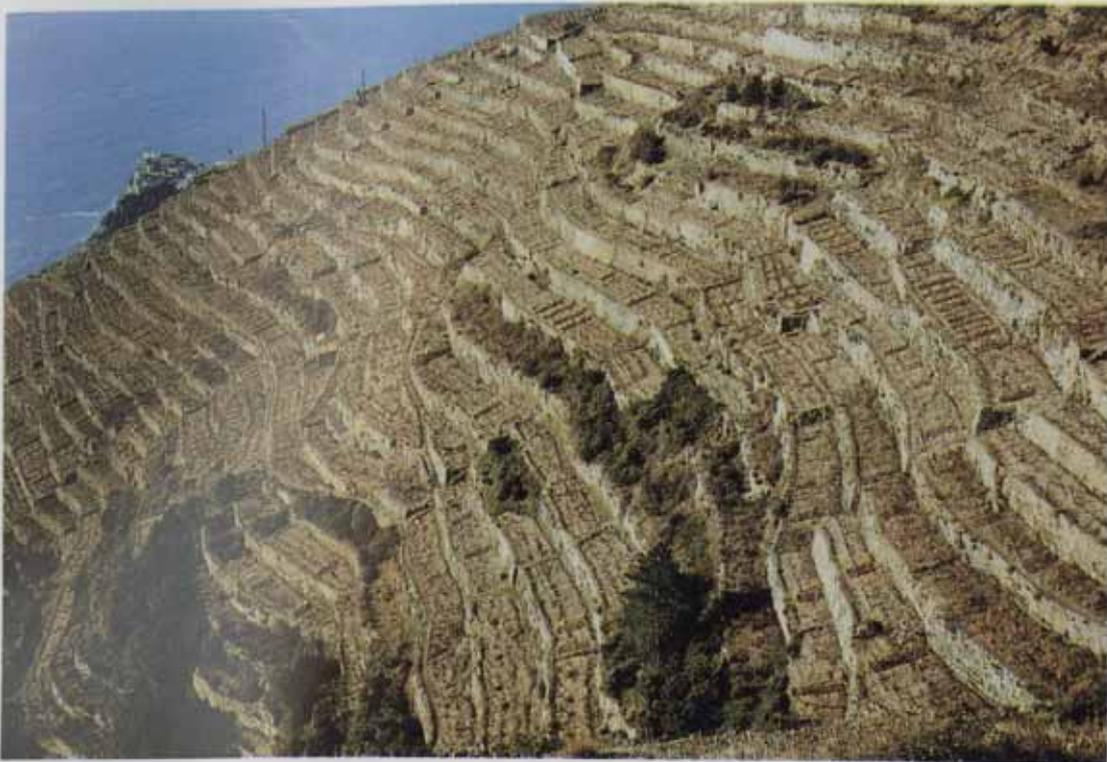
Fot. 10. - Zona di Volastra. La foto, ripresa nel mese di gennaio, mostra in veste invernale un particolare dei terrazzi destinati alla viticoltura, poggianti sul substrato del macigno, disposti con i muri di sostegno secondo le isoipse e collegati qua e là da muri di spina lungo il pendio (foto Terranova R.).
