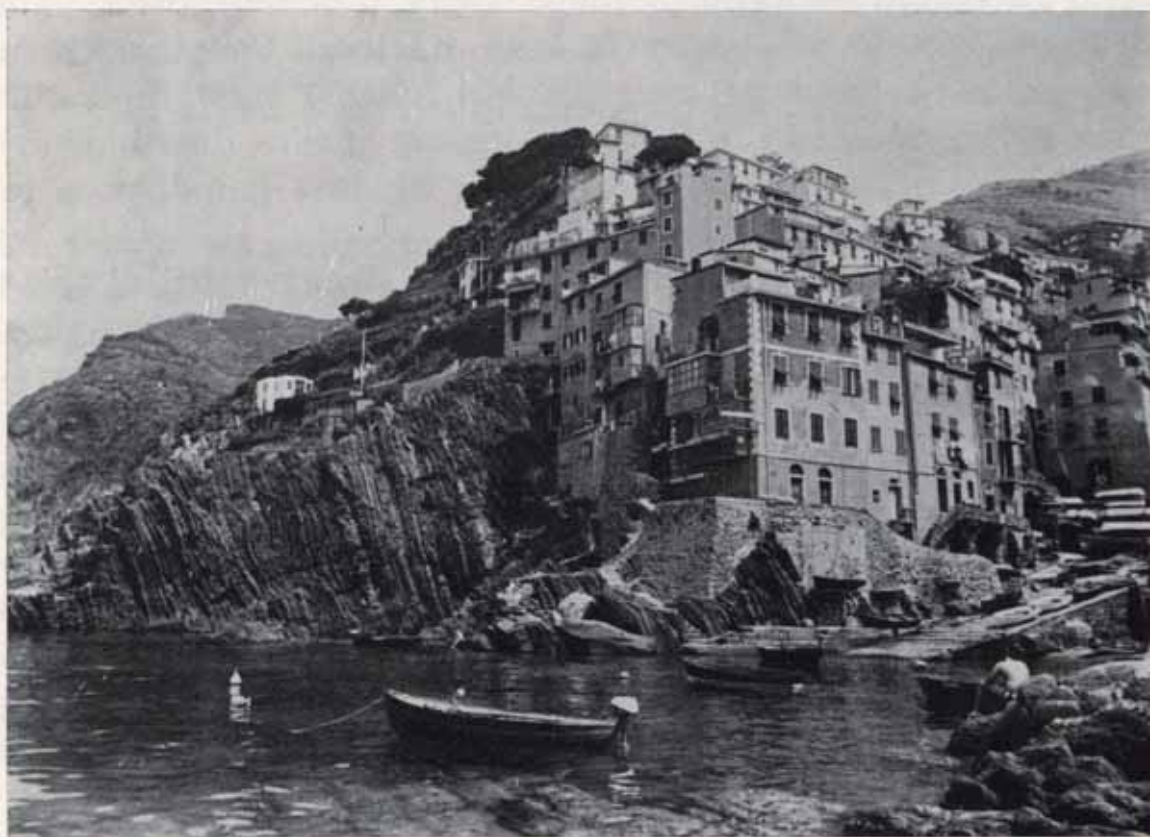
Fig. 8. — La parte a mare dell'abitato di Riomaggiore poggia su un potente pacco di strati di arenarie zonate del Macigno, disposti in giacitura subverticale o reggipoggio rispetto alla fascia costiera.
