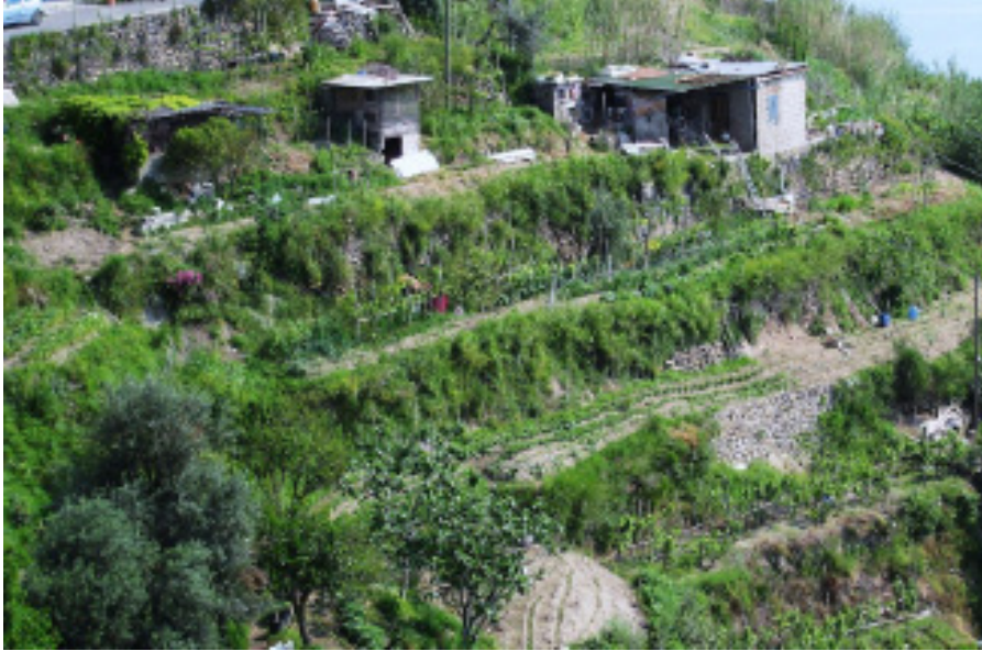
Fig. 4 - Terrazzi costruiti con pietre a secco di natura lavica sulle pendici del monte dei Vezzi
