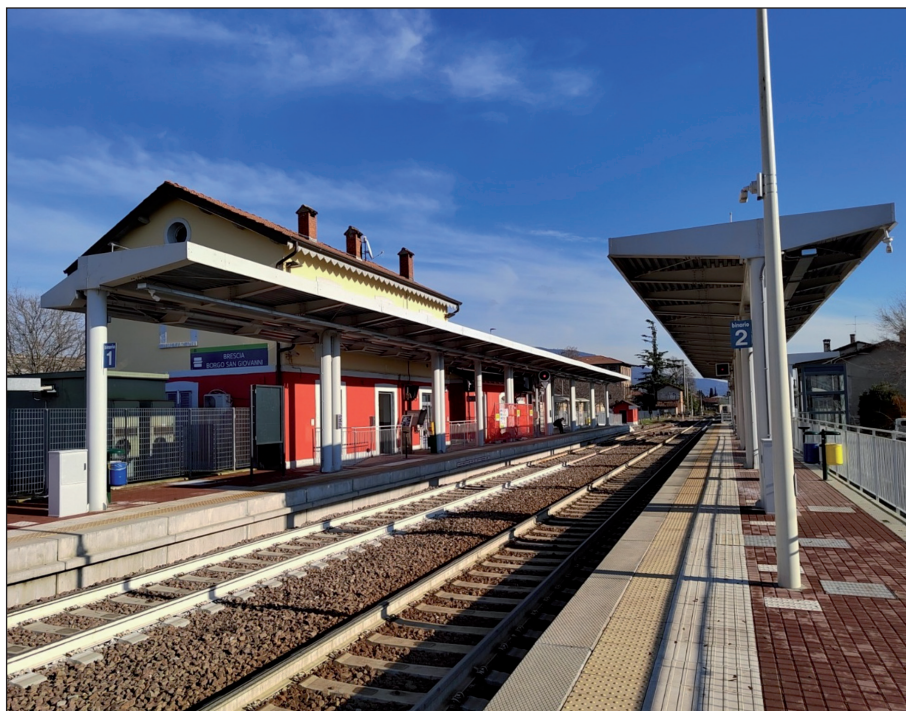
Fig. 25 - La stazione di Borgo San Giovanni così come si presenta oggi
