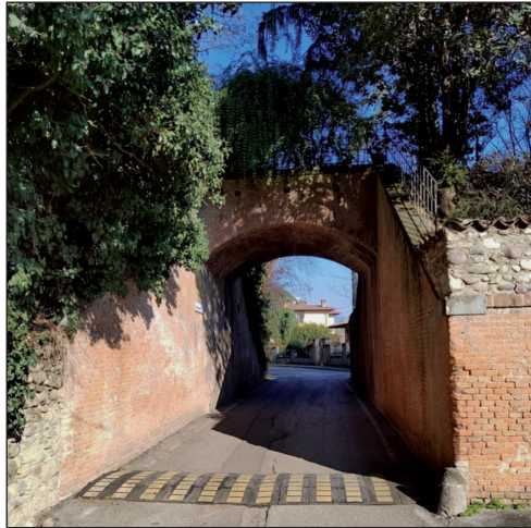
Fig. 17 - Il ponte presso l'ex stazione di Passirano Superiore
