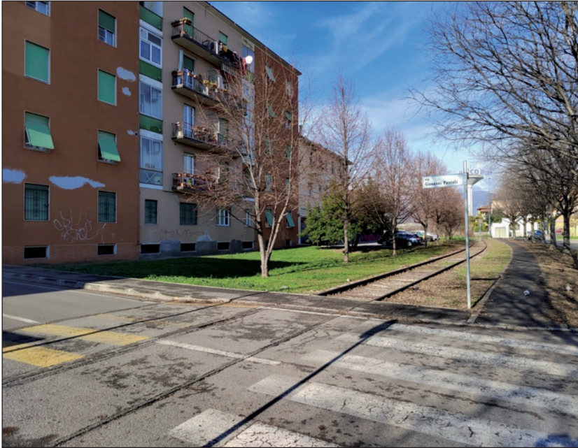
Fig. 28 - L'interruzione del raccordo presso via Giovanni Pascoli. Si noti l'asfalto deformato nell'area sovrastante i binari
