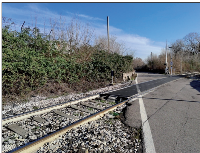
Fig. 22 - L'inizio del raccordo dell' OM - Iveco e Sant'Eustacchio oggi scollegato dalla linea in seguito alla recente sostituzione del binario. I primi 200 metri sono in preda alle malerbe ed in totale stato di abbandono
