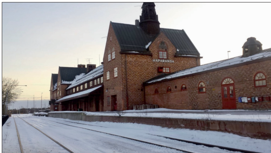
Foto 1 - La stazione di confine di Haparanda (1915). In primo piano i due binari a scartamento maggiorato (1.524 mm) provenienti dalla limitrofa rete finlandese
