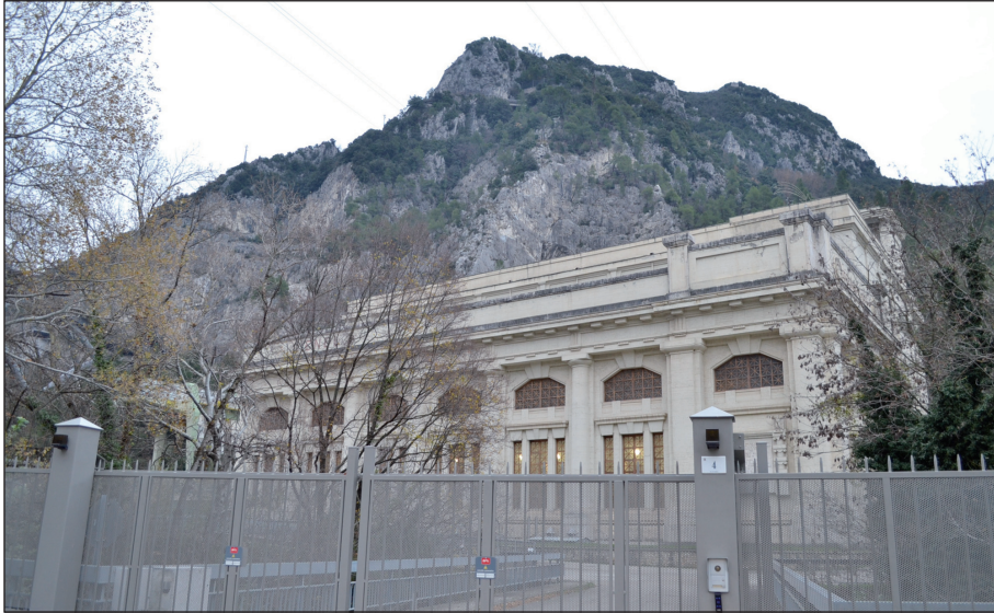
Foto 1 - La centrale idroelettrica di Galleto - Monte Sant'Angelo
