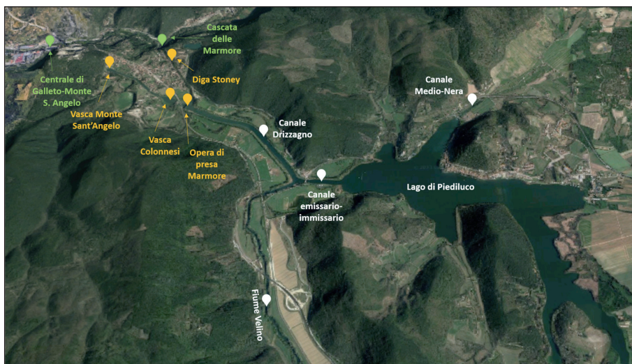
Fig. 3 - Vista della Centrale di Galleto, del canale Drizzagno e delle altre opere connesse
