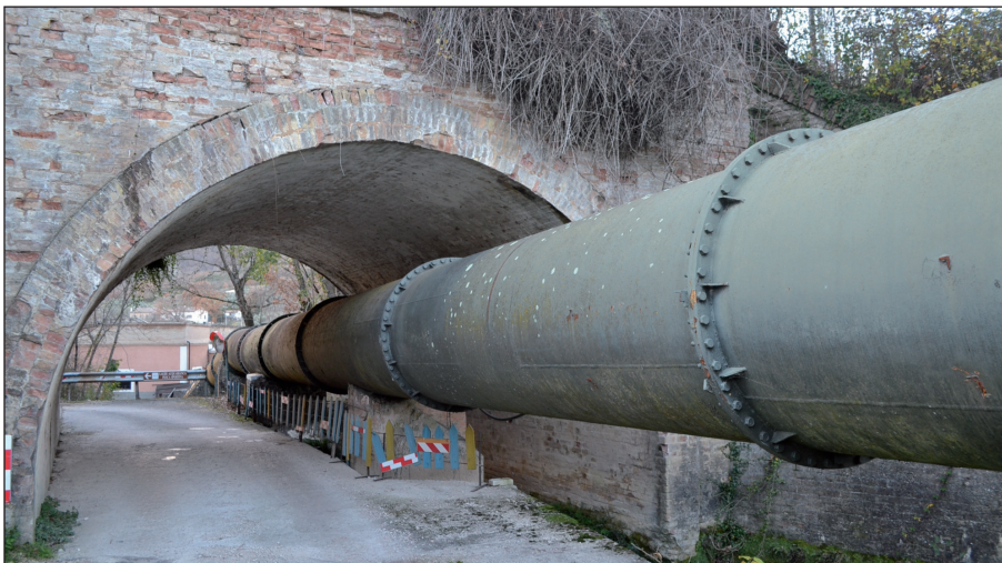
Foto 8 - L'acquedotto della centrale di Pontecentesimo
