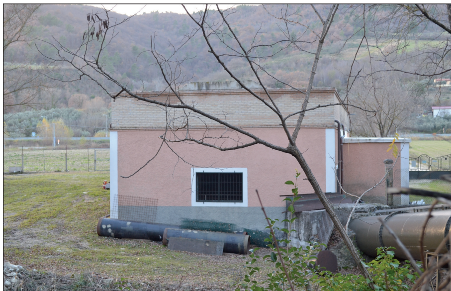
Foto 9 - La centrale di Pontecentesimo
