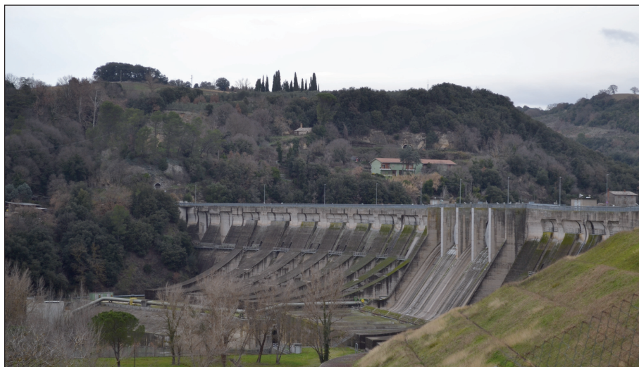
Foto 4 - L'imponente diga che sbarra il Tevere nei pressi del Castello di Corbara che si vede al centro della foto
