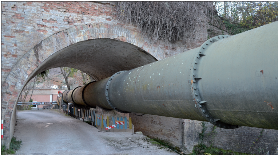
Foto 8 - L'acquedotto della centrale di Pontecentesimo
