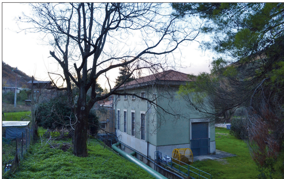
Foto 10 - L'acquedotto e la centrale dell'Altolina
