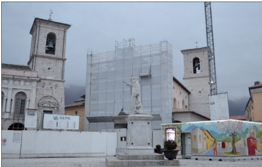
Foto 9 - La piazza di Norcia e la basilica di San Benedetto in fase di ricostruzione
